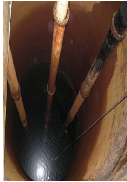
伏流水收集井(輻射井) 之內部
