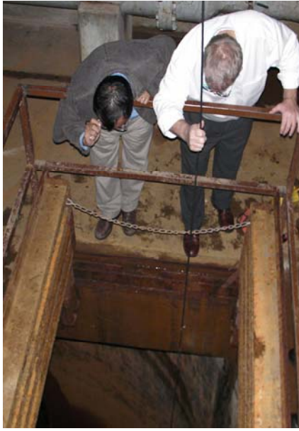
伏流水收集井(輻射井) 之內部
