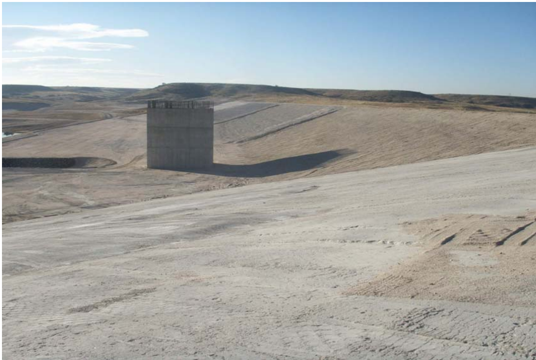
照片 10 Reuter-Hess Dam 大壩加高工程（施工中）
