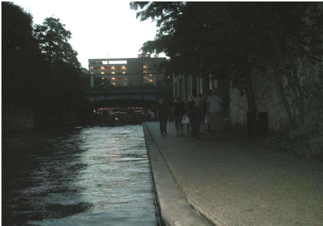
照片十八 聖安東尼奧河岸整治工程
