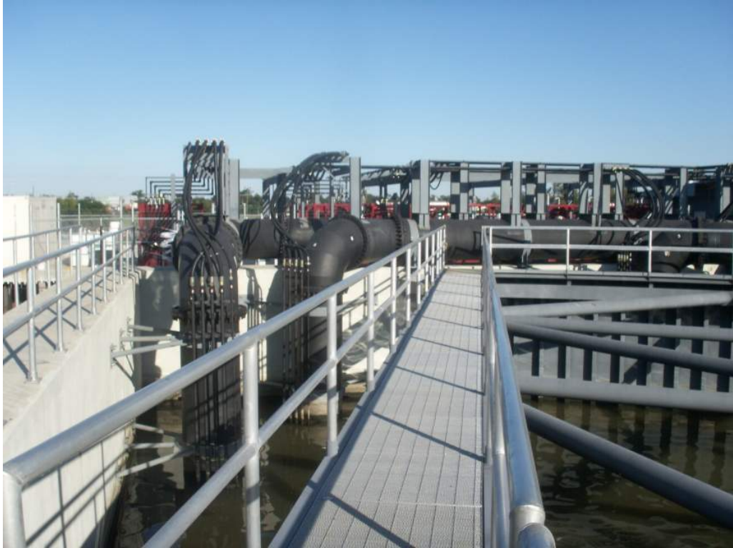
照片十三 卡崔那風災復建工程之一(抽水站工程)
