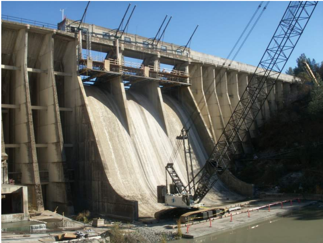
照片十九 石峽大壩更新改善工程(溢洪道)
