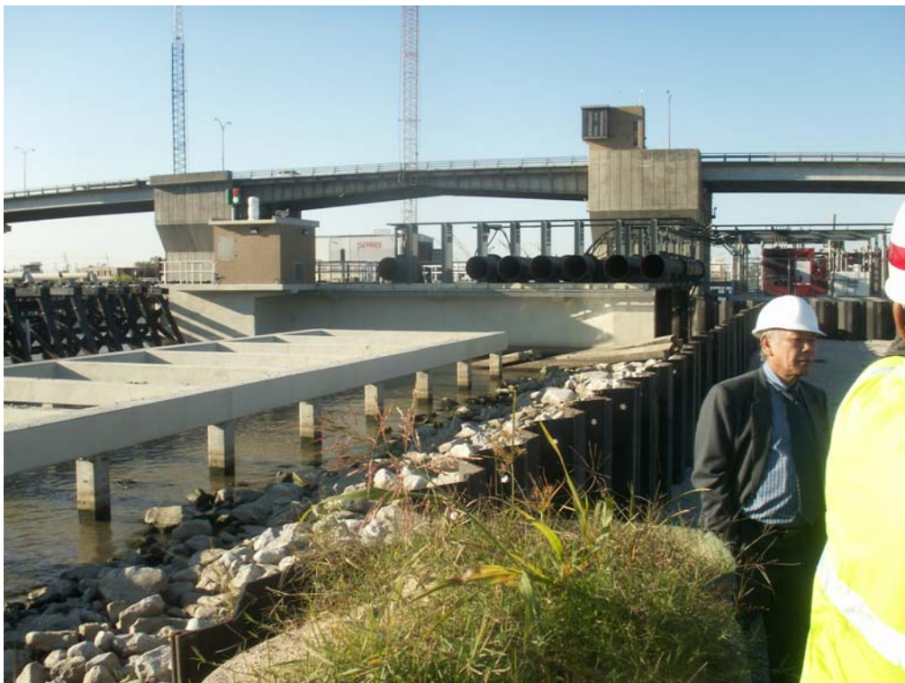
照片十四 卡崔那風災復建工程之一(堤防復建)
