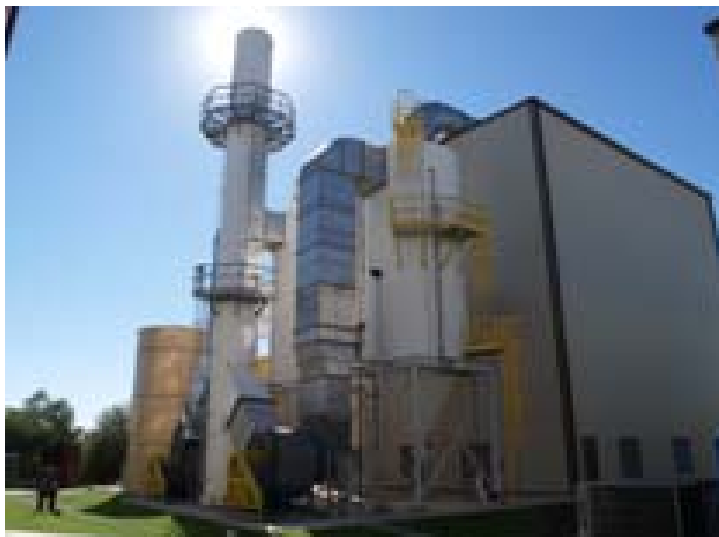
泡沫滅火實驗館外觀
