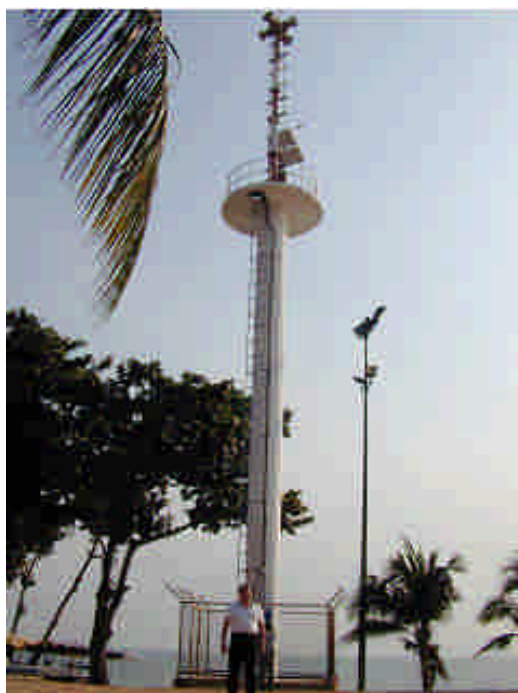
泰國國家災害警報中心設於芭達雅市(Pattaya)海岸邊的海嘯警報塔。
