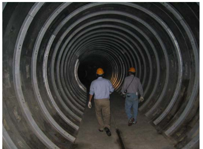
圖 2-2 161kV 深美~台北線 地下潛遁隧道工程
