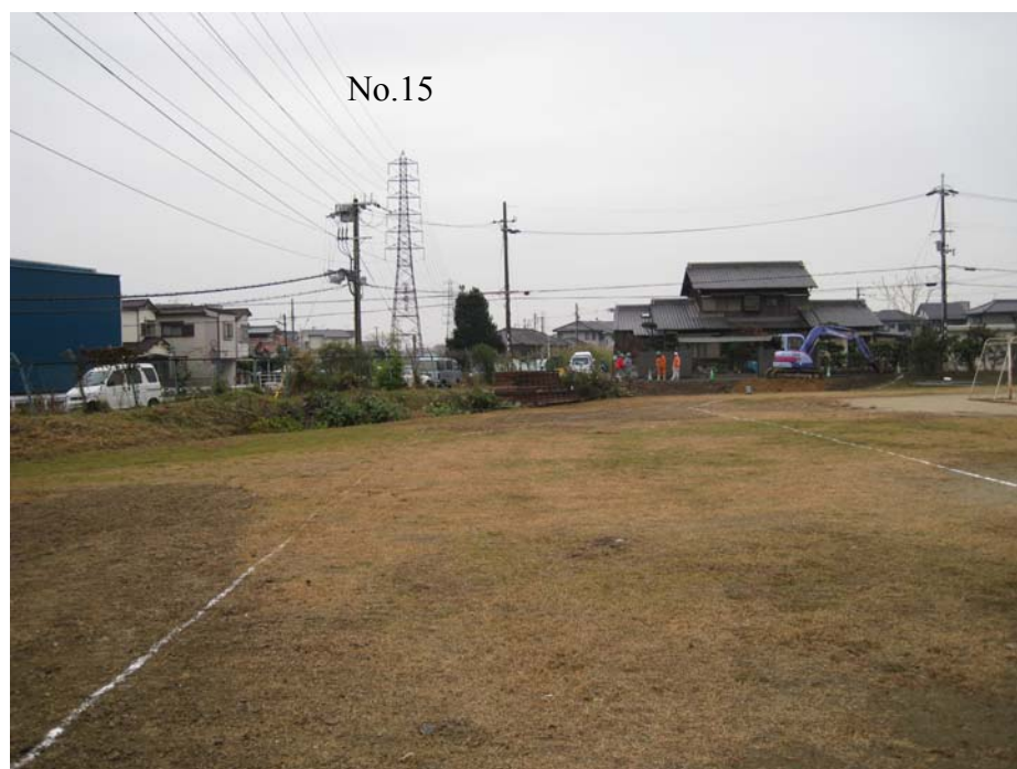
圖 4-13 現事工事準備、交通疏導及施工動線規劃
