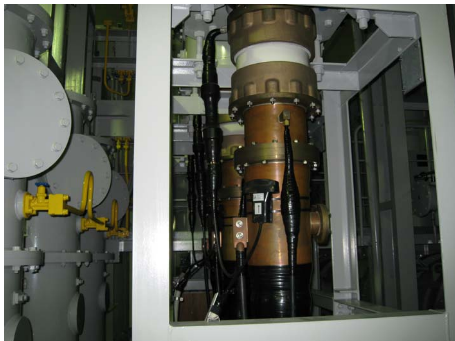
圖 4-7 275kV 氣封型電纜終端匣（EBG）
