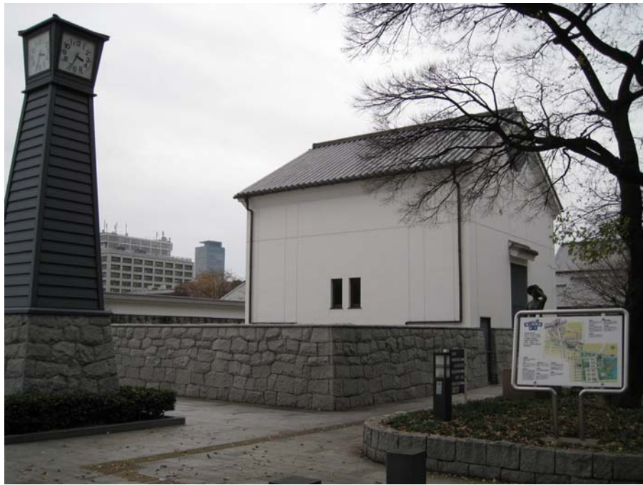
圖 4-10 名城變電所入口處之建築外觀與周圍環境
