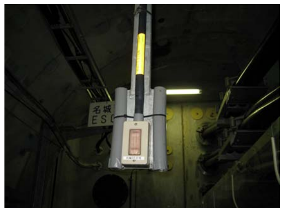
圖 3-28 洞道情報收集裝置
