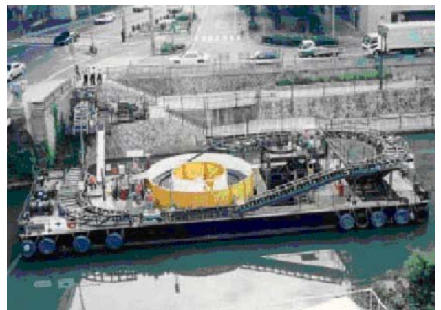
圖 3-8 電纜由台船延放入洞道情形
