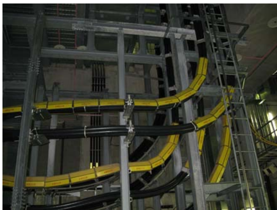
圖 3-18 多回線電纜爬升固定
