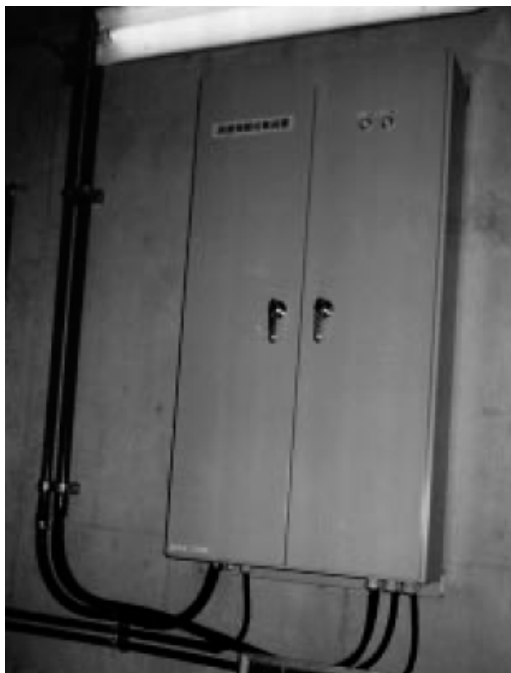
圖 3-32 洞道訊息收集裝置外觀
