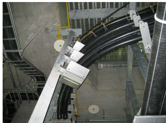
圖 3-19 電纜轉彎保持適當彎曲半徑
