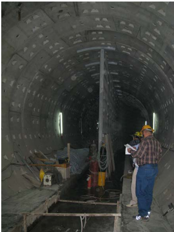
圖 2-1 345kV 頂湖~仙渡線 地下潛遁隧道工程
