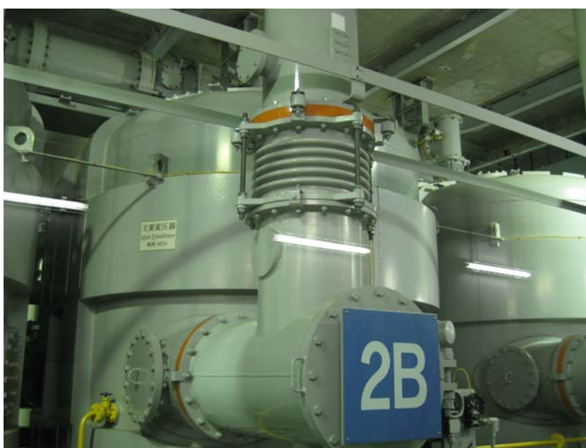
圖 4-3 主變壓器（防火型）
