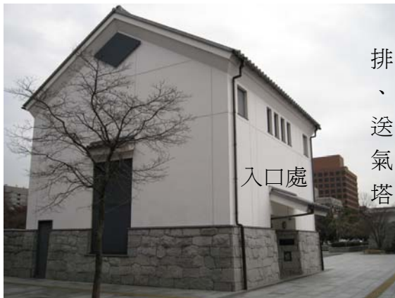
圖 3-23 名城變電所排送氣塔
