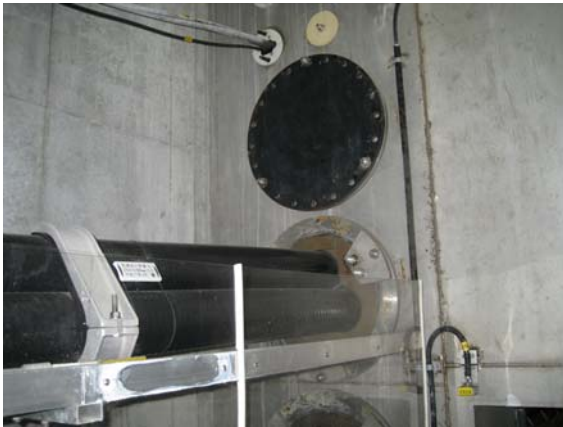
圖 3-16 275kV 名城～松ヶ枝線
