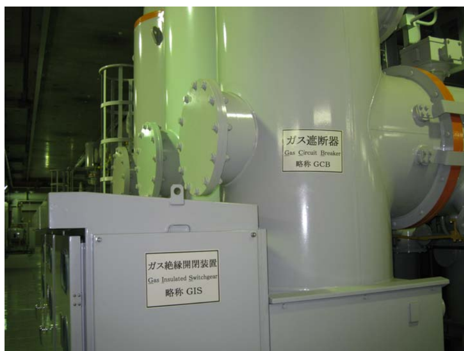
圖 4-6 GIS設備（SF 6 為絕緣材料）
