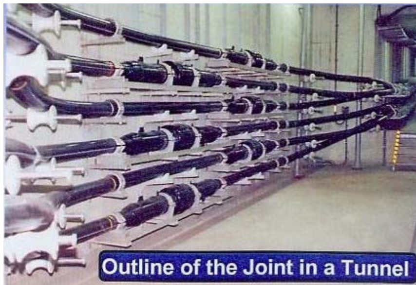
圖 3-5 洞道內 EMJ 型接續匣實際裝置情形
