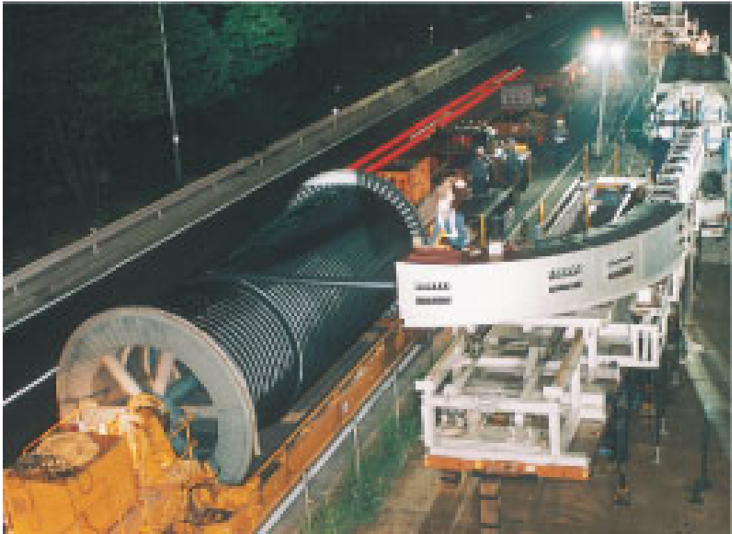
圖 4-23 長尺電纜生產製造及安裝 (500kV 新京葉~豐州線)
