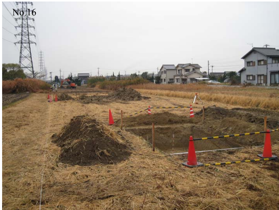
圖 4-14 臨時鐵塔之基礎開挖作業
