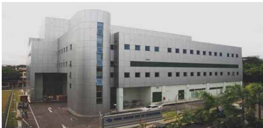
圖 5.5：超高壓變電所
