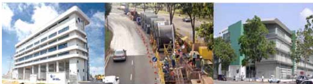
圖 4.9：光纖與電纜同時電纜鋪設
