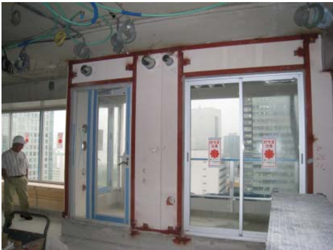
圖 17 清水建設港區管理局集合住宅室內隔間及配線工程
