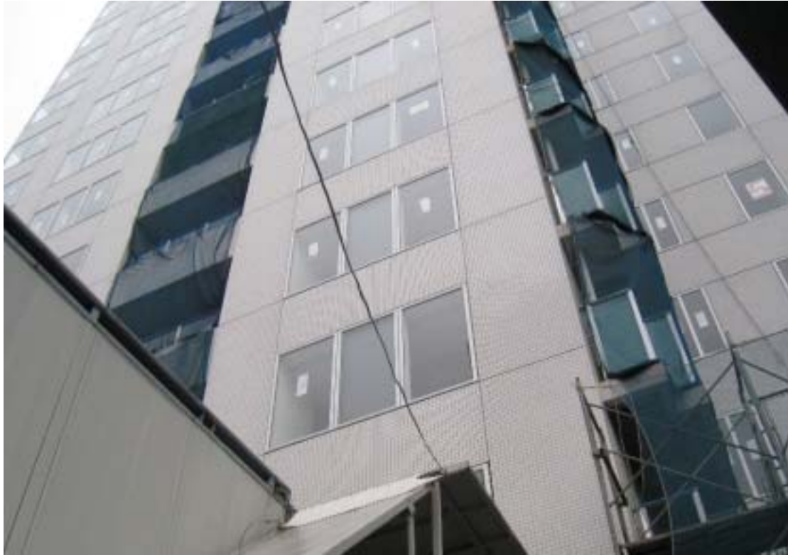
圖 16 清水建設港區管理局集合住宅工程已完成的外牆帷幕牆組裝
