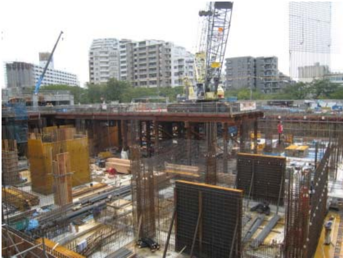
圖 20 帝京大學附屬醫院工程大面積開挖之地下室（筏基底部的隔震層已完成）
