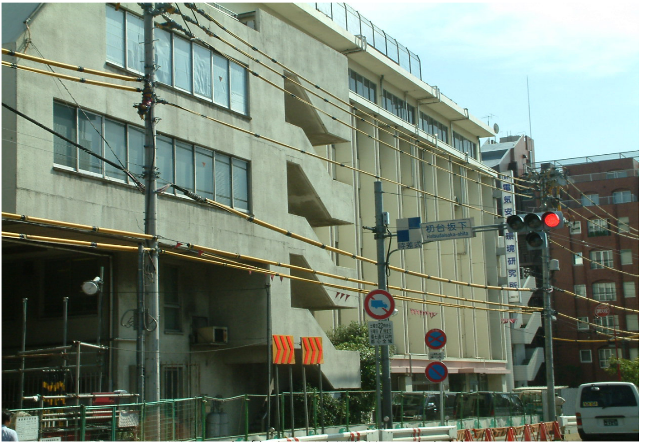
圖 5、日本電氣安全環境研究所(JET)東京本部
