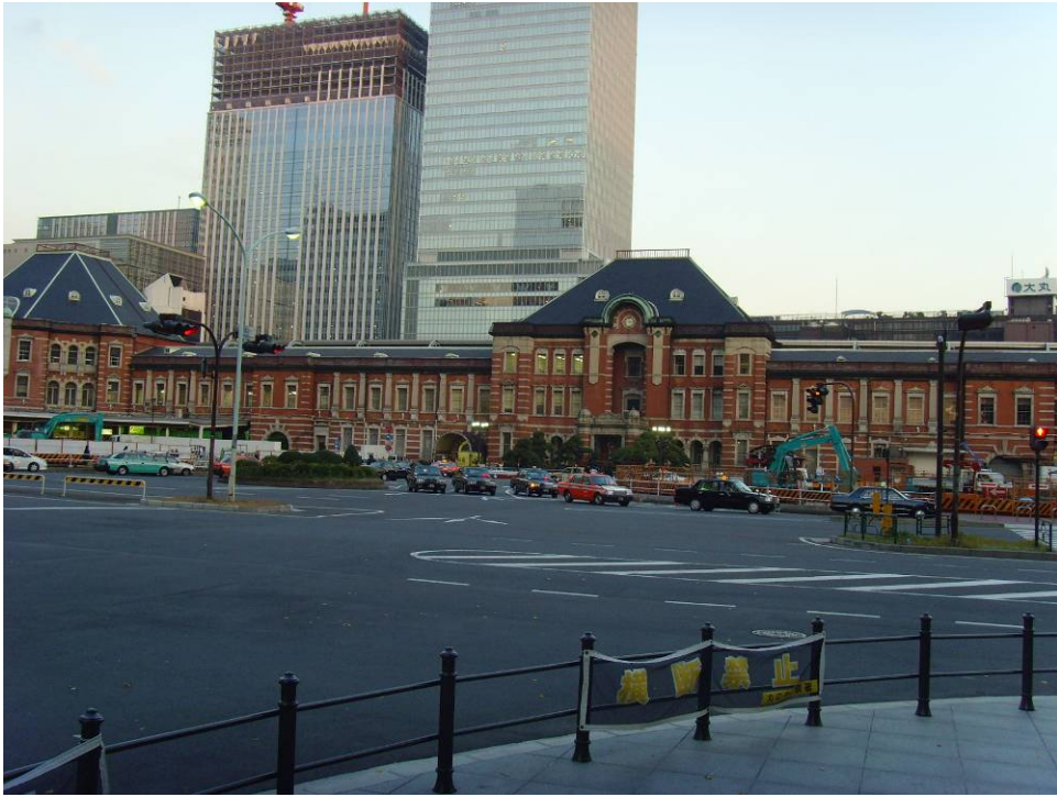
丸之内側車站（中央口）
