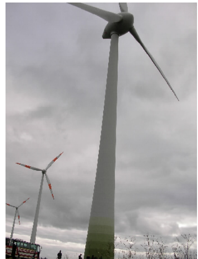
(左) Enercon E-112 風力機主體 (無齒輪箱設計, 額定發電功率: 4.5/6 MW) (右) Enercon E-112 整機 (葉片直徑 113 m; 塔架高度 125m)
