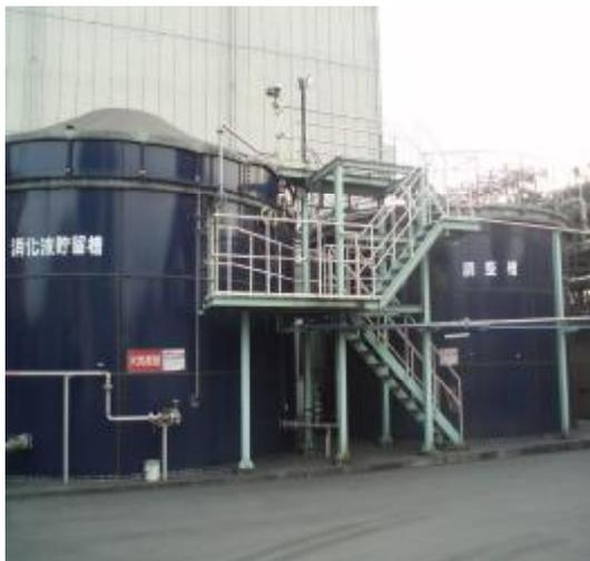
圖 23. 調整槽及消化液貯留槽
