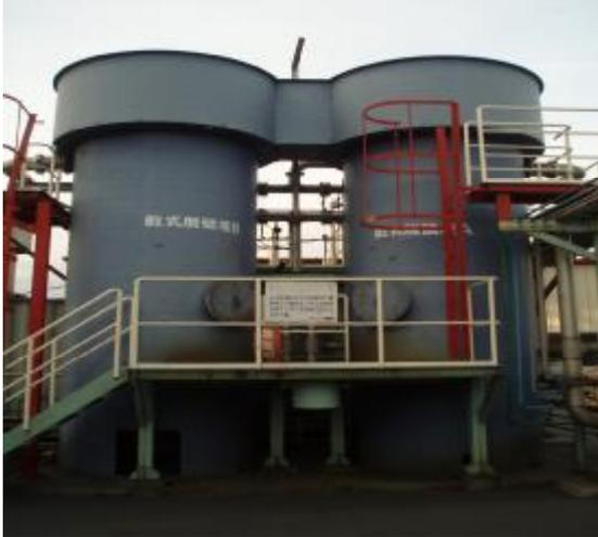
圖 27. 醱酵產氣脫硫設備
