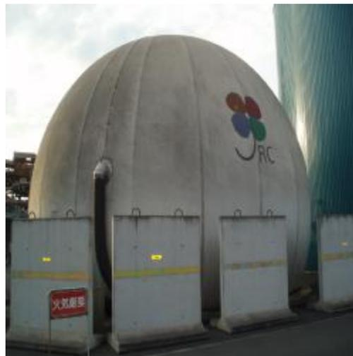
圖 24. 可燃性氣體貯存槽
