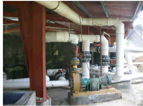
Achotines 海洋實驗所黃鰭鮪種魚飼育池排水沉澱過濾及管路設施
