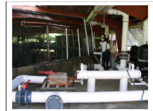
Achotines 海洋實驗所黃鰭鮪種魚飼育池之沙濾及紫外線殺菌系統
