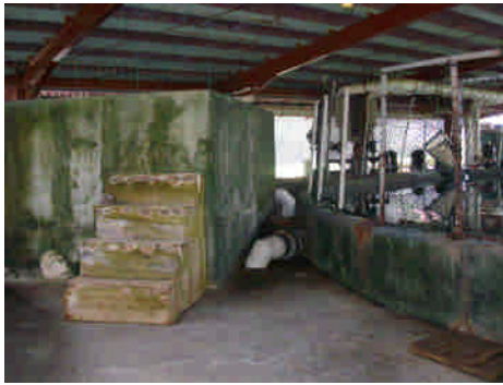
Achotines 海洋實驗所黃鰭鮪種魚飼育池排水沉澱過濾及管路設施
