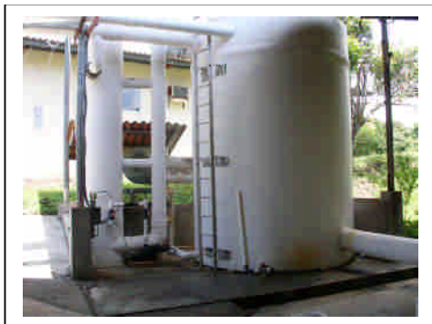
Achotines 海洋實驗所黃鰭鮪種魚飼育池之沙濾及紫外線殺菌系統
