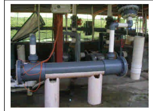
Achotines 海洋實驗所黃鰭鮪種魚飼育池之沙濾及紫外線殺菌系統
