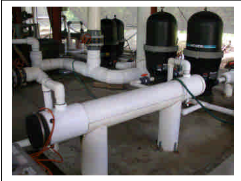
Achotines 海洋實驗所黃鰭鮪種魚飼育池之沙濾及紫外線殺菌系統
