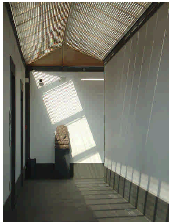
空間廊道-光影變化 疊加式的廊頂和木色網形天窗，使得自然採光呈現豐富的面貌
