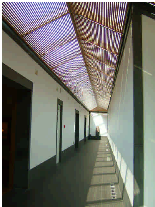
空間廊道-光影變化 疊加式的廊頂和木色網形天窗，使得自然採光呈現豐富的面貌
