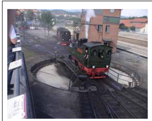
扇型蒸汽機車庫有詳細的解說牌
