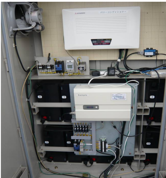
圖 6 PV 系統電氣設備之箱體
