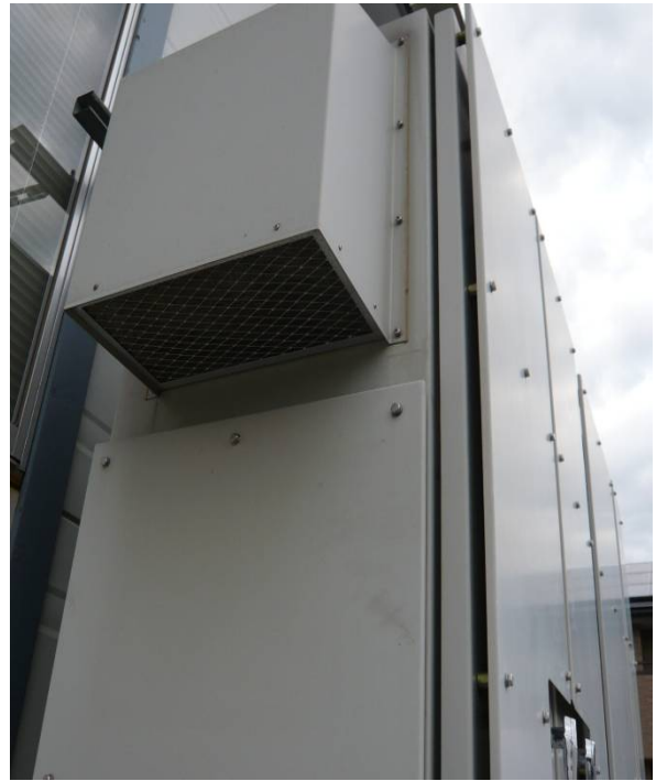
圖 7 向下設計之散熱通風口
