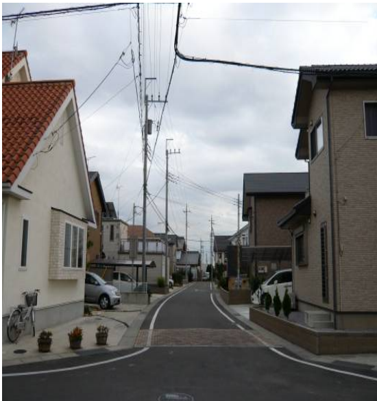
圖 40 非地下化的電力系統
