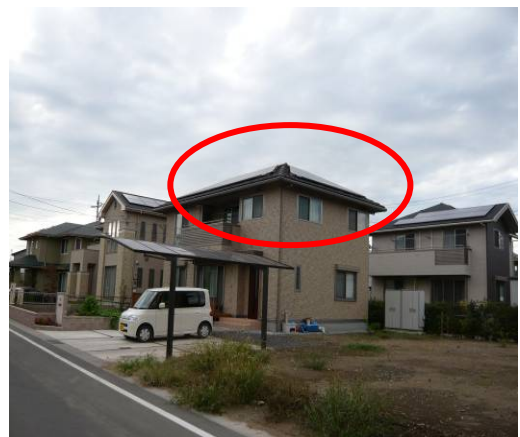
圖 37 多角度的系統會採用 Multi-string Inverter
