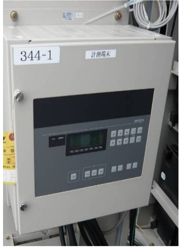
圖 15 明電舎之 Measurement Unit
