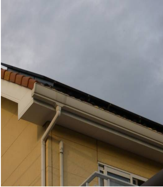
圖 38 非屋瓦整合型的 PV 模組， 只是 Mount 上去。
