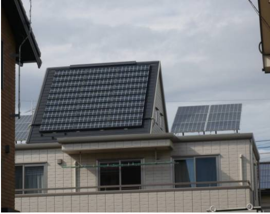
圖 32 斜屋頂的太陽光電組列
