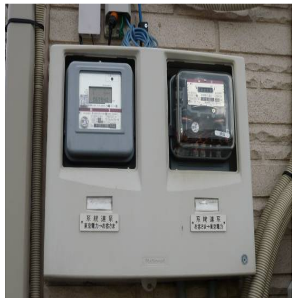
圖 41 瓦時計，左數位錶買電， 右機械錶賣電
