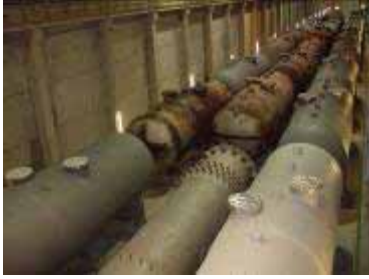
圖 20、德國 EWN/Greifswald 電廠除役大型組件中期貯存
