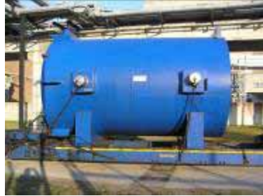
圖 21、德國 EWN/Greifswald 電廠除役大型組件運送
