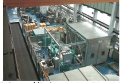
圖 22、德國 EWN/Greifswald 檢整除污設施：高壓水
