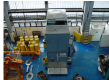
圖 24、德國 EWN/Greifswald 檢整除污設施： 噴砂研磨
