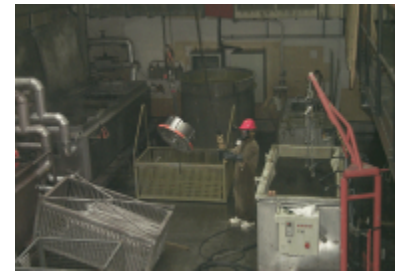
圖 25、德國 EWN/Greifswald 檢整除污設施： 化學及電化學除污槽
