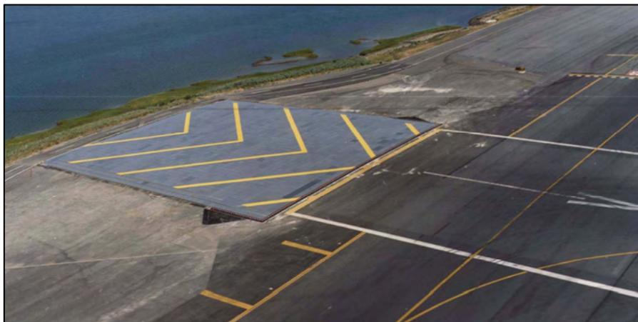
圖 16 EMAS 完工後外觀照片
