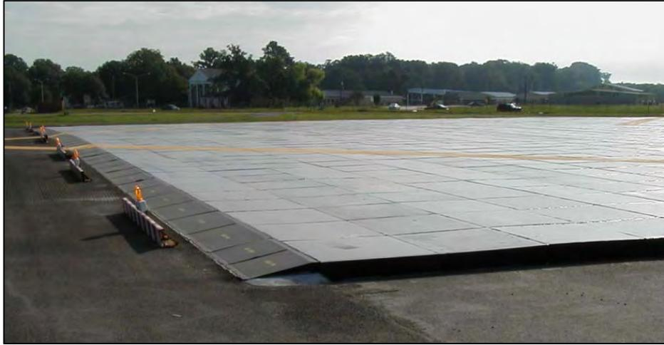
圖 19 EMAS 接近跑道端之導入面 (Lead In Ramp)
