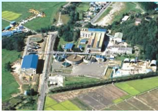
圖 4.3-1 洗淨設施全景
