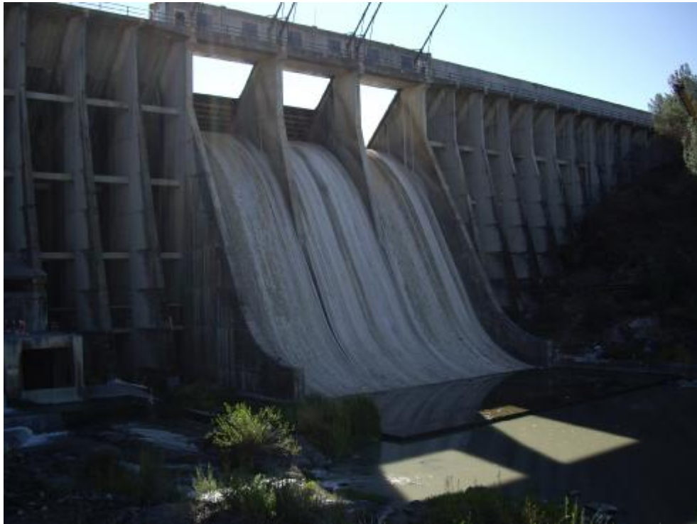
壩體及溢洪道
