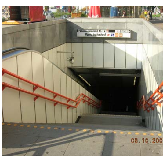
照片 6-1 維也納市區地鐵站入口
