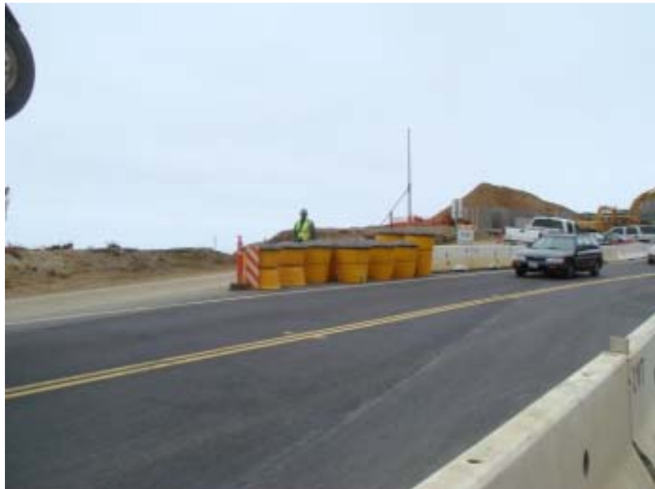
加州舊金山 Devil ' s Slide 地滑整治工程外圍道路鼻端之防撞設施
