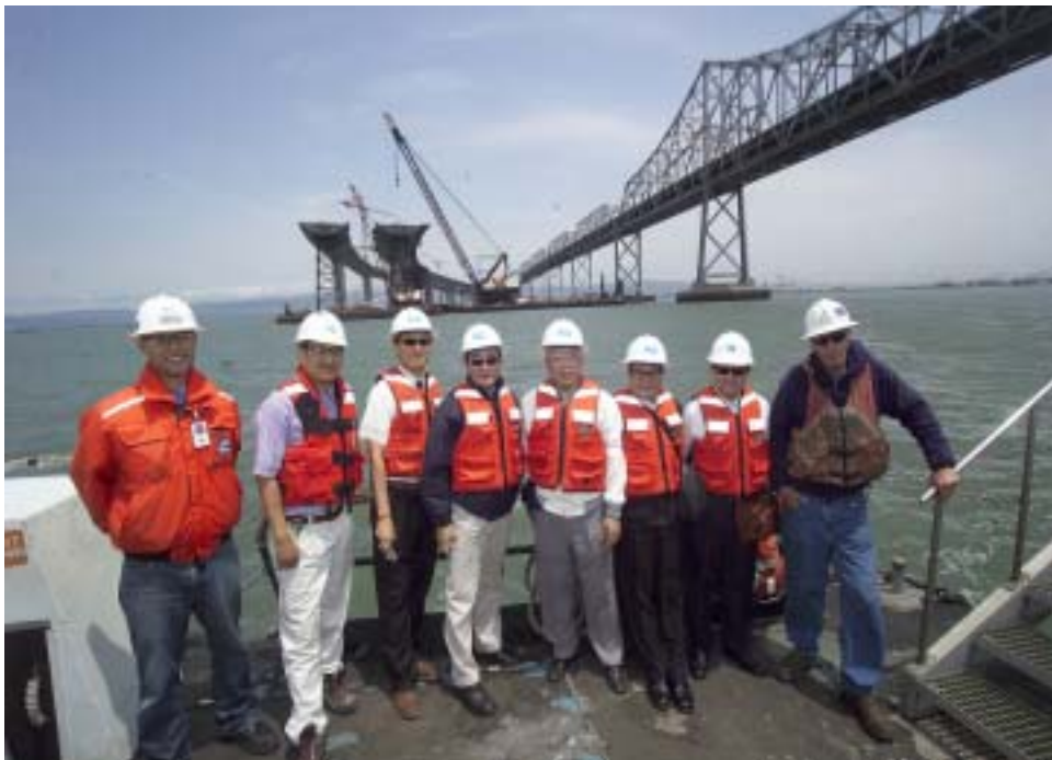
搭乘工程交通船考察加州舊金山 Bay Bridge 海上施工作業情形
