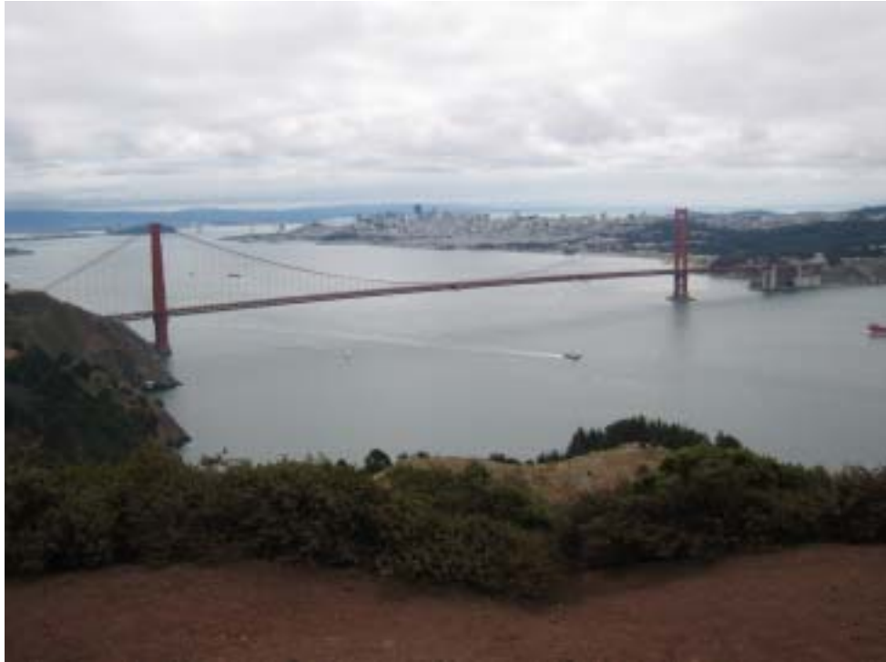
考察美國加州舊金山 Golden Gate Bridge 交通規劃及營運維護
