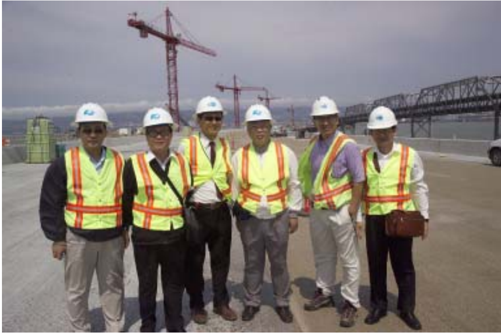
於美國加州舊金山 Bay Bridge 橋面版考察鋪面施工情形
