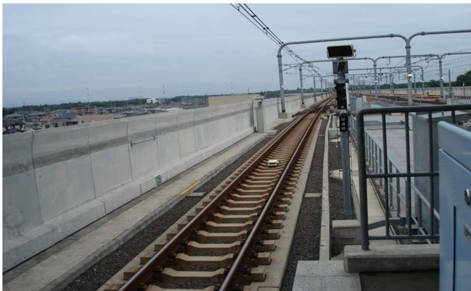
照片 3 常磐新線高架路段
