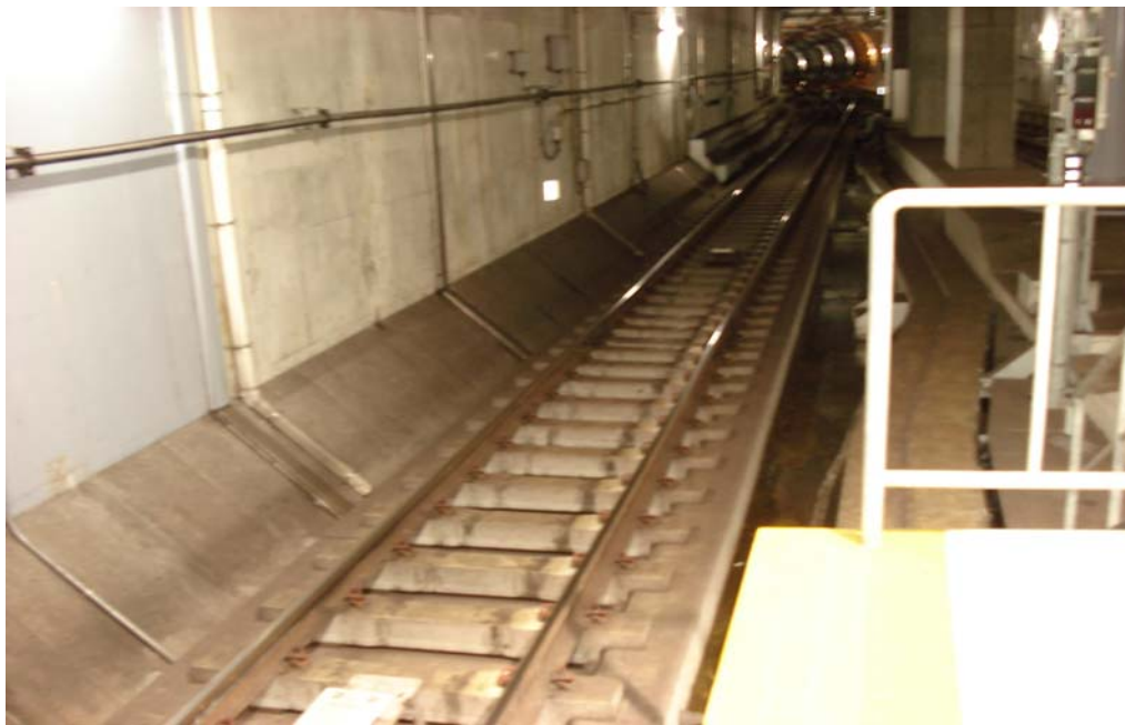
照片 1 常磐新線地下隧道路段
