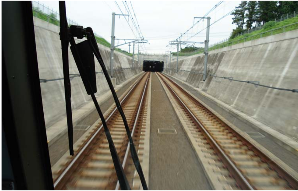
照片 2 常磐新線路塹路段
