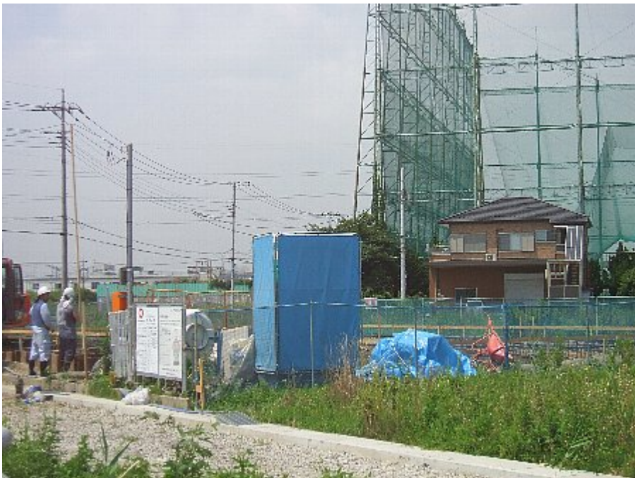
照片 9 八潮車站附近，施工中之集合住宅工地
