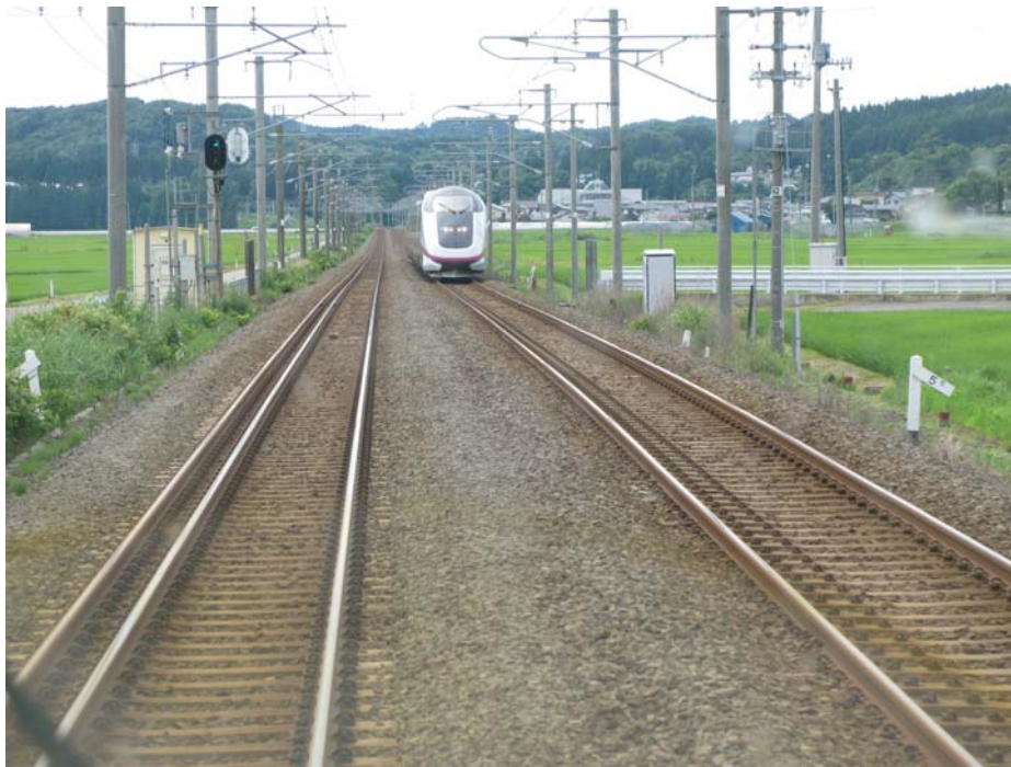
照片 15 神宮寺站-峰吉川站間，除標準軌外，亦鋪設第三軌
