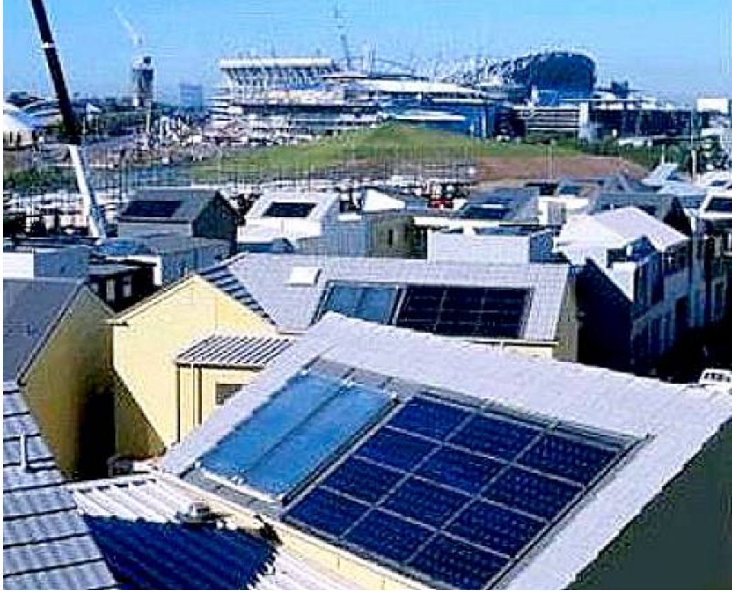
圖2.1.3 興建中的奧運體育館與部份完成的住宅
