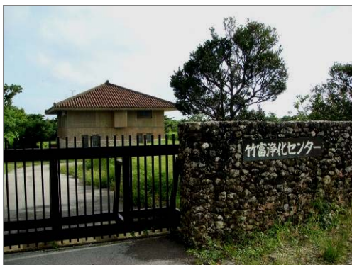
照 72 竹富淨化處理廠（楊博淵，2007）
