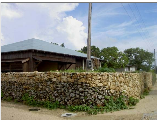
照 104 修復石牆（紀麗美，2007）
