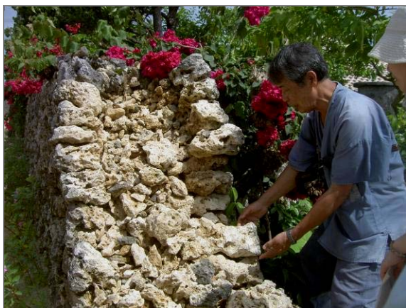
照 106 解說石牆修復工法。一旁可見石牆上四處綻放著九重葛（紀麗美，2007）
