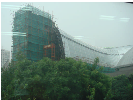
北京中央美院設計學院附設美術館施工狀況
