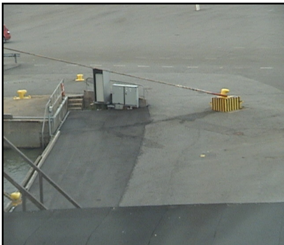
郵輪泊靠繫纜設施
