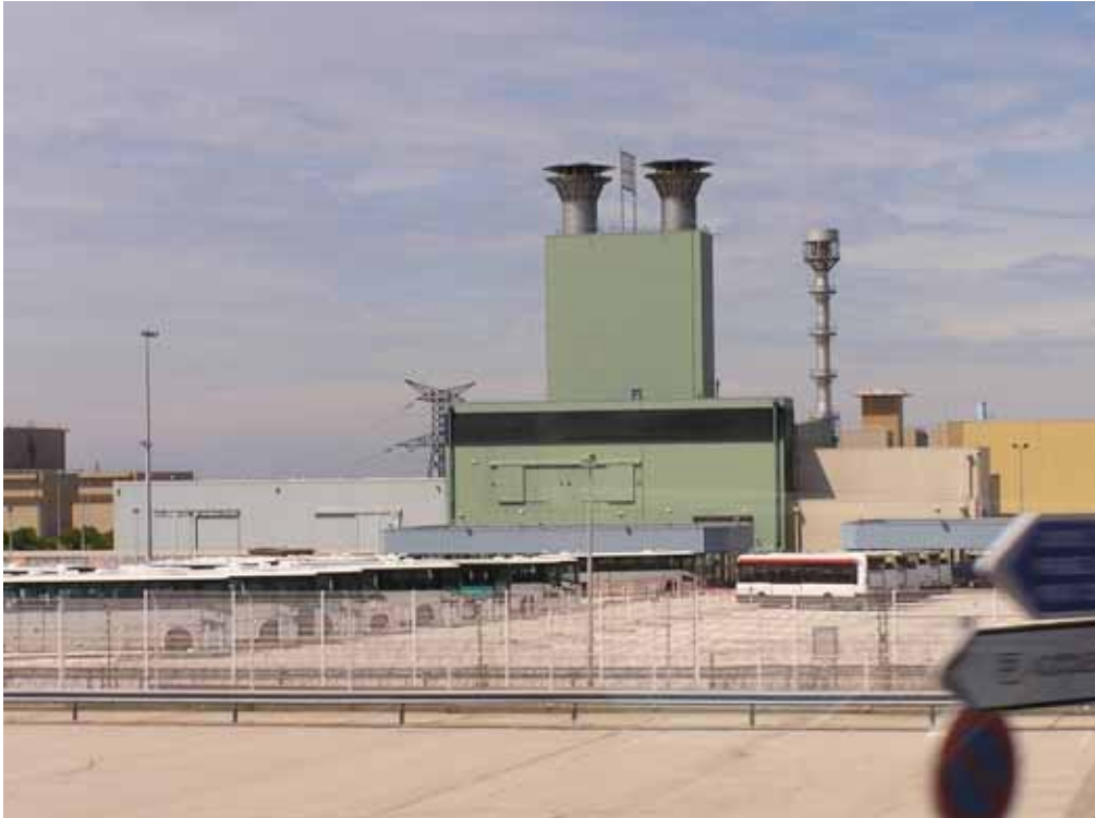
圖 6 La Hauge 廠內固化體中期儲存場(Atelier E/EV) (圖中綠色建築物，由巴士與建築物比例可知該儲存場佔地很小)
