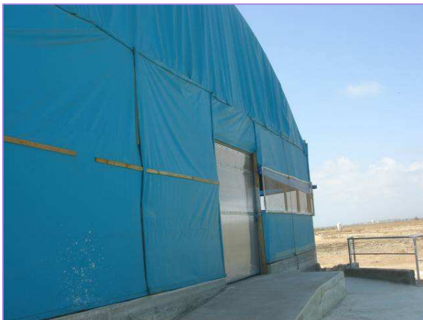
建築中石斑溫室
