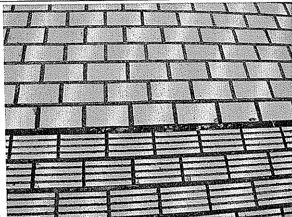
同一種花色，但粗糙度不同的地磚。在斜坡處的地磚有橫向止滑凹條。
