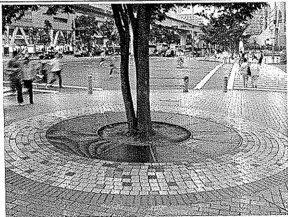
台場的人行道植栽，利用馬賽克鋪面增加視覺刺激，以平坦密貼之鑄鐵架，讓植栽能有更多的集水與生長空間
