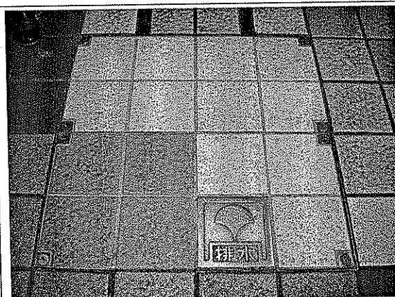
排水溝陰井的頂蓋
