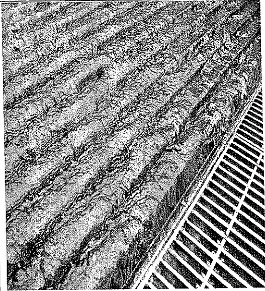
凹槽之設計為往內斜約 30 度角，每一階水集滿後，才向下一階溢出，所以看起來水流層落有序，而不會顯的急促。
