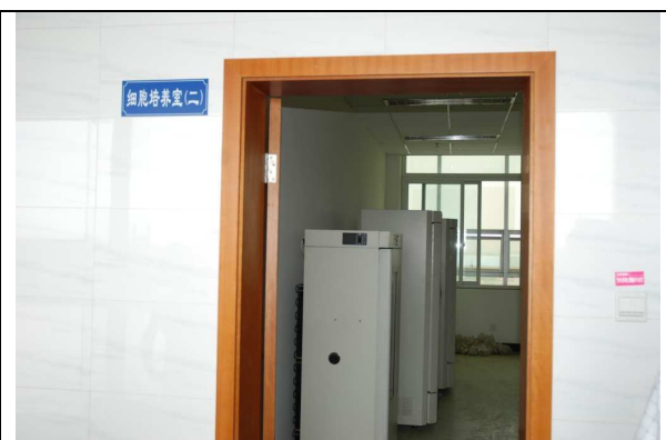
2. 研究大樓內的貴重儀器室
