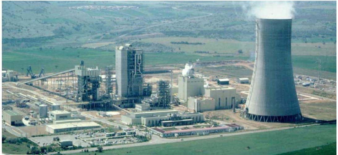
圖 28、西班牙 Elcogas IGCC 發電廠鳥瞰圖
