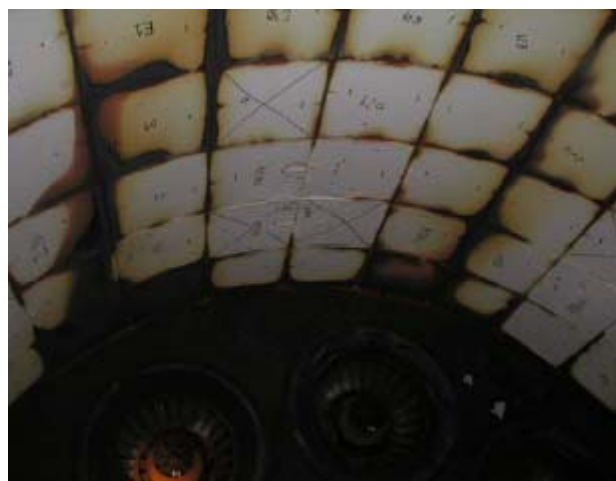
圖 37、煙道內隔熱陶瓷
