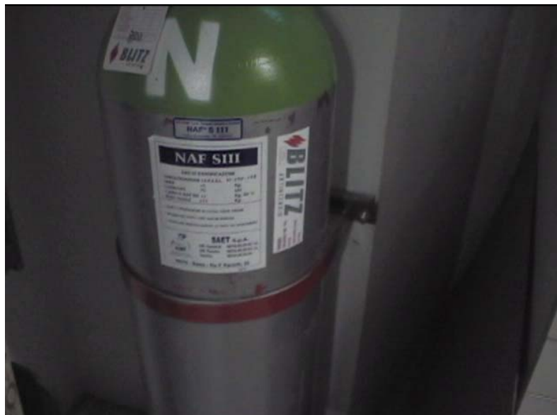
圖 3-2-11 羅馬國家檔案館使用的自動化潔淨氣體滅火系統(NAF S-III)
