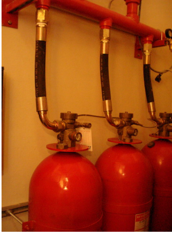
圖 3-2-4 ICPL 所使用的自動化潔淨氣體滅火系統（NAF S-III）
