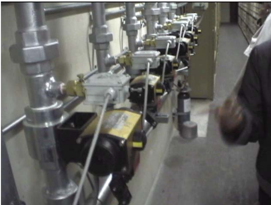
圖 3-2-7 佛羅倫斯國家檔案館使用的自動化潔淨氣體滅火系統(IG-55)
