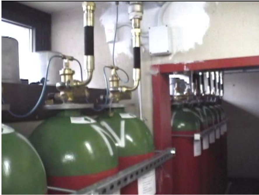
圖 3-2-6 佛羅倫斯國家檔案館使用的自動化潔淨氣體滅火系統(IG-55)
