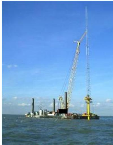
圖 4.1.(4).2 Burbo 測風塔施工
