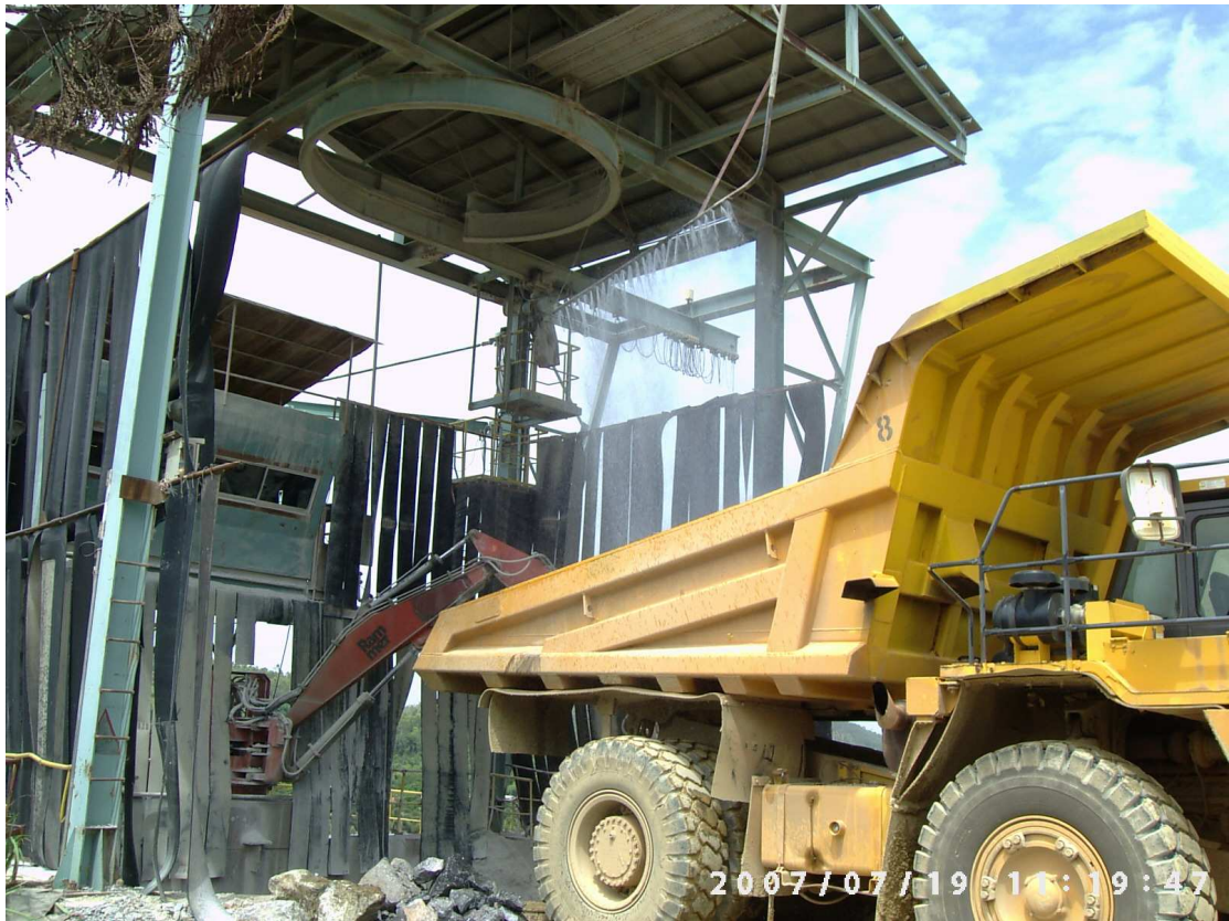
圖二 水泥礦場之水泥礦石投料口及自動灑水防塵設備(2007.07.19)
