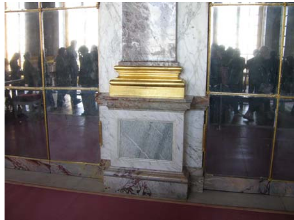
修復完成的鏡廳壁柱
