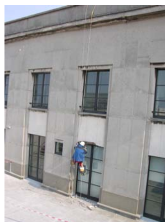
夏優學院頂樓修復施工
