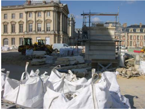
凡爾賽宮大門廣場上的地坪整修 (物料器材置放)
