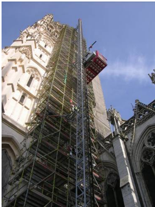
參訪人員搭乘電梯至塔樓參觀 教堂格局與石雕修復
