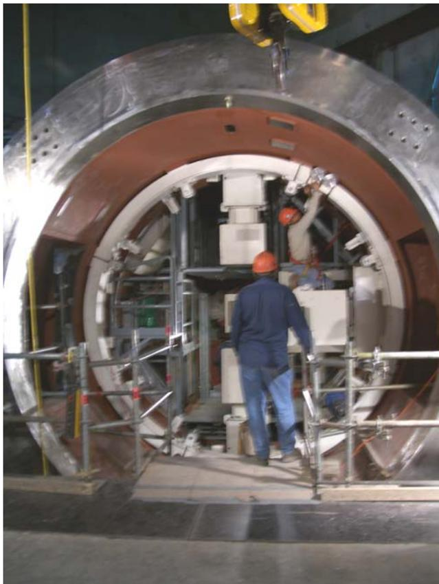
圖二：proton center 的 gantry system
