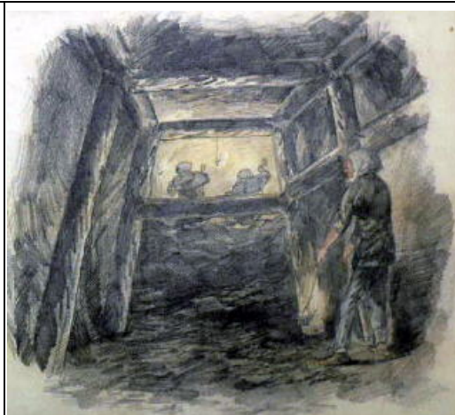
↑ 長等山隧道導坑挖掘(明治 19 年開始做)
