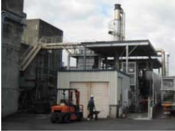
屠宰場內焚化爐
