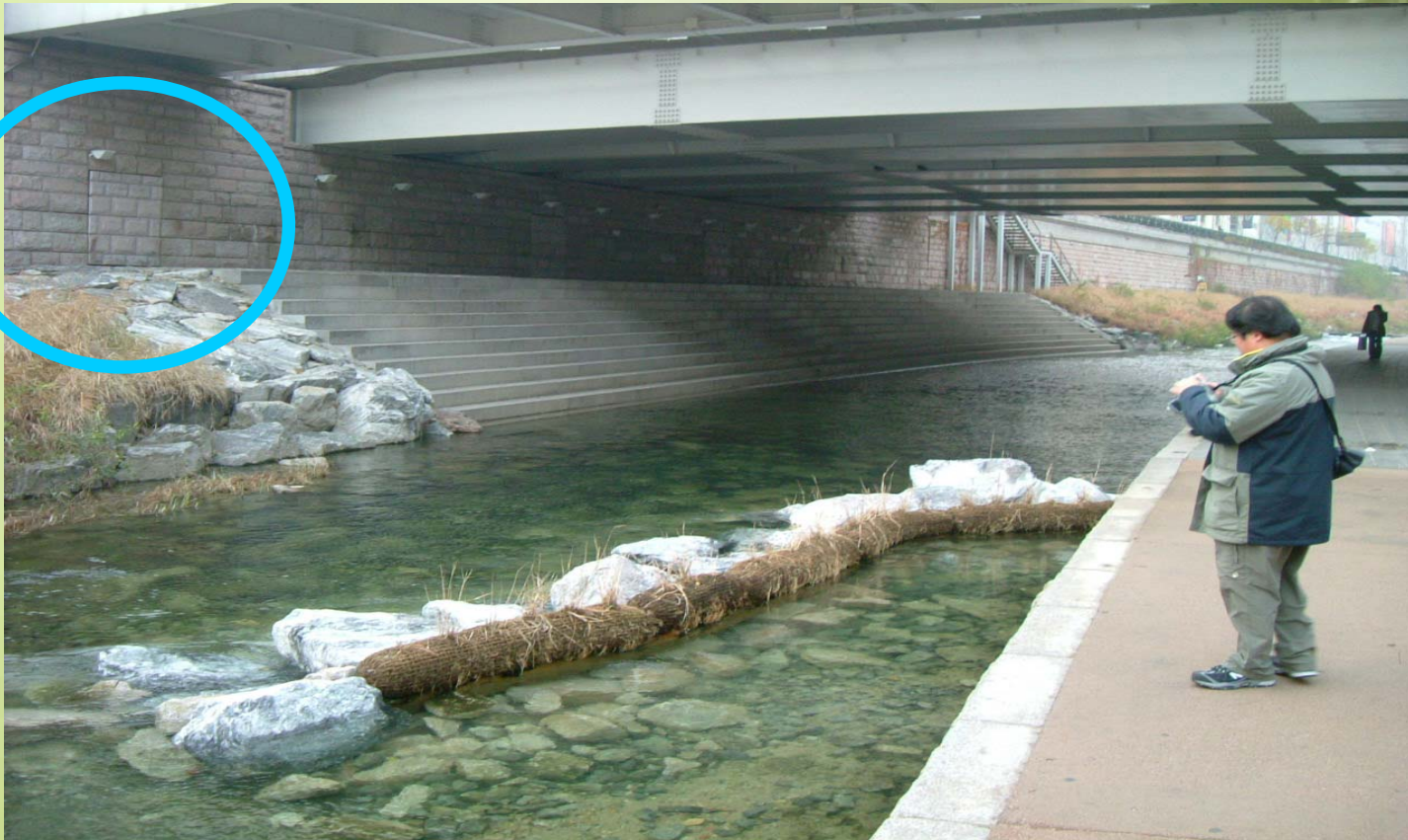
單向開口的自動排洪閘門
