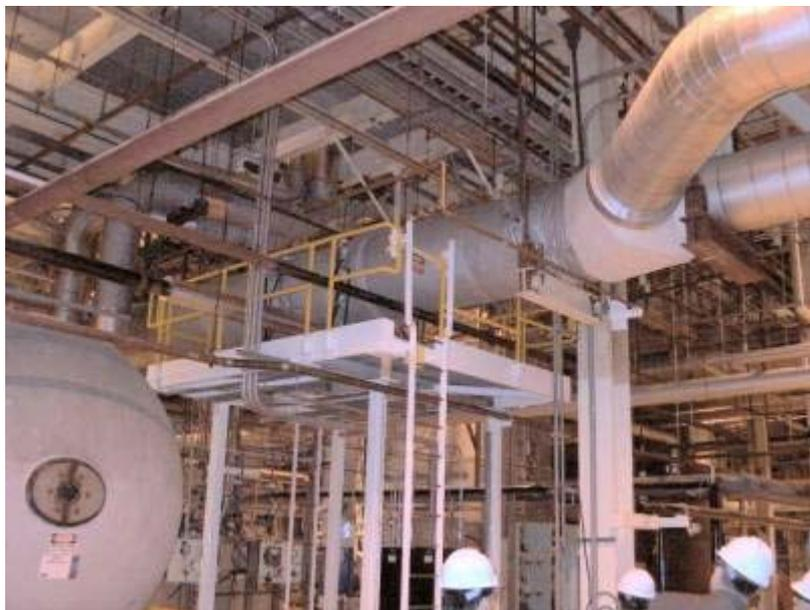
在電廠人員陪同下進入 1 號機汽機廠房反應爐飼水系統飼水集管處，汽機廠房走道相當寬敞，且比核二廠的汽機廠房明亮。1 套 LEFM 流量計安裝於飼水控制閥上游的飼水集管上，離地面約 4.5 米，外面同飼水集管以隔熱保溫材料包裹，只露出 16 支 Transducer，LEFM 流量計周圍有設置一高架維護工作平台，以便於電廠人員執行維護作業（核二廠目前尚未規劃高架維護工作平台，劉宗興股長回來將建議核二廠考慮設置。）；LEFM 流量計的電氣盤安裝於高架維護工作平台正下方，電氣盤為一雙併式盤，右側盤為主要監控盤，左側盤為 4 小時的不斷電系統(UPS)盤(核二廠只有一監控盤)。電氣盤周圍相當寬敞，亦便於電
