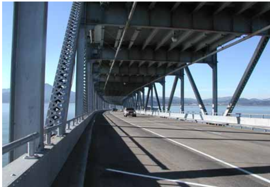
橋梁分上下兩層橋面
