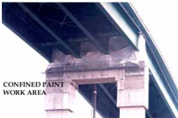
鋼橋油漆施工情形(CalTrans 提供)
