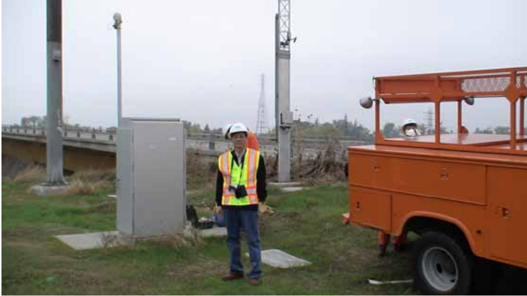
進入鋼箱梁內部之前
