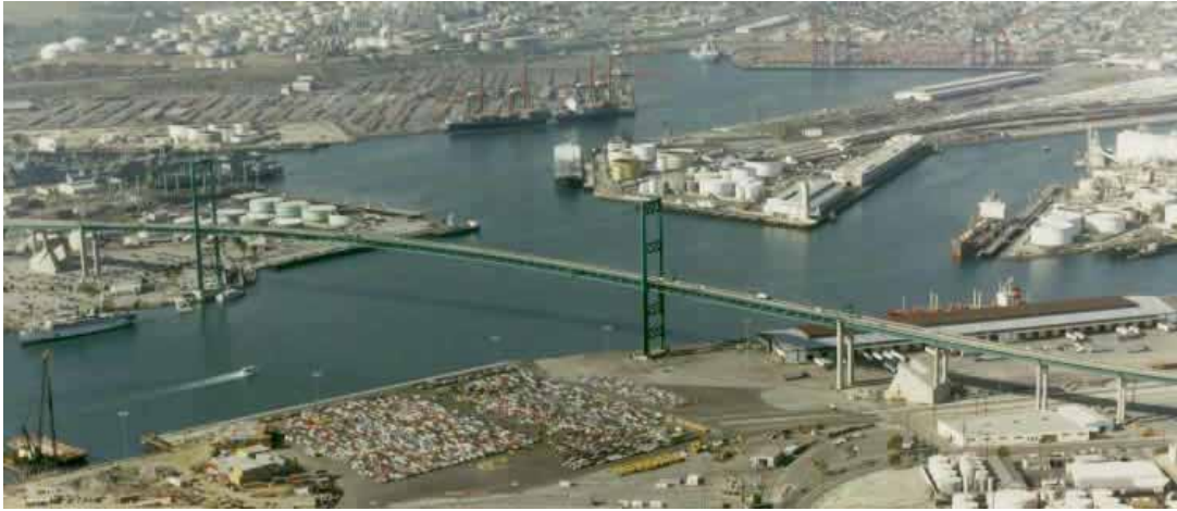
Vincent Thomas 橋梁(CalTrans 提供)
