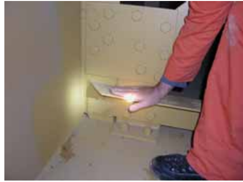
底下橫向框架加勁版連接處有裂縫
