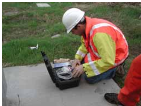
進入箱梁內部前利用 Micro MAX Pro 廢氣偵測
