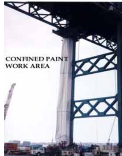
鋼橋油漆施工情形(CalTrans 提供)
