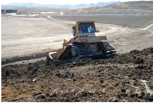
圖 37 封閉掩埋場邊坡整理
