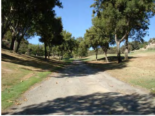
圖 7 垃圾沉陷所導致路面不平
