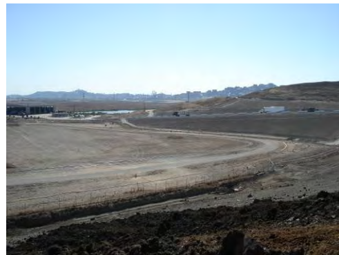
圖 36 完成封場工程之部分
