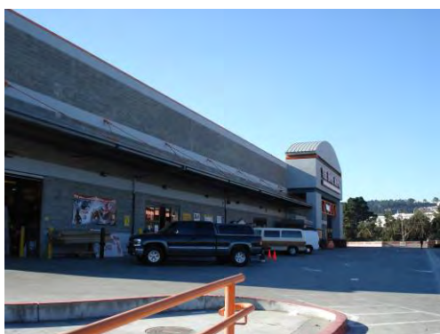
圖 29 Colma Home Depot
