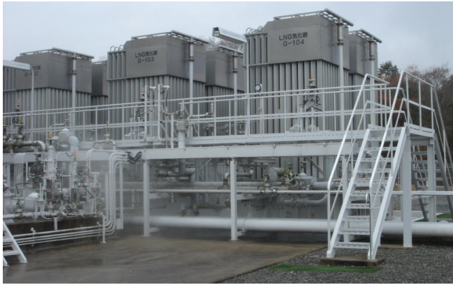
西播磨衛星站氣冷式氣化器
