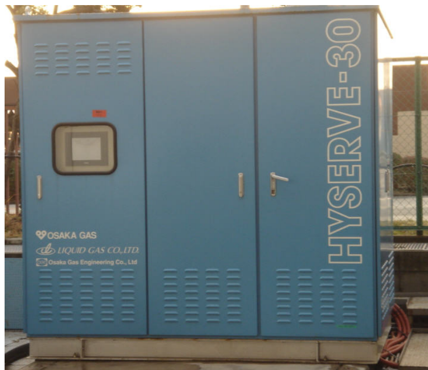
大阪瓦斯公司研發之 NG 重組氫氣產製設備
