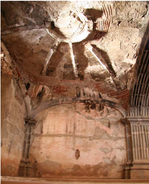
修女彌撒小教堂，因1976年大地震致屋頂倒塌。 原屋頂殘蹟（左圖）；1993年採碳纖維拱狀屋頂保存殘蹟（右圖）
