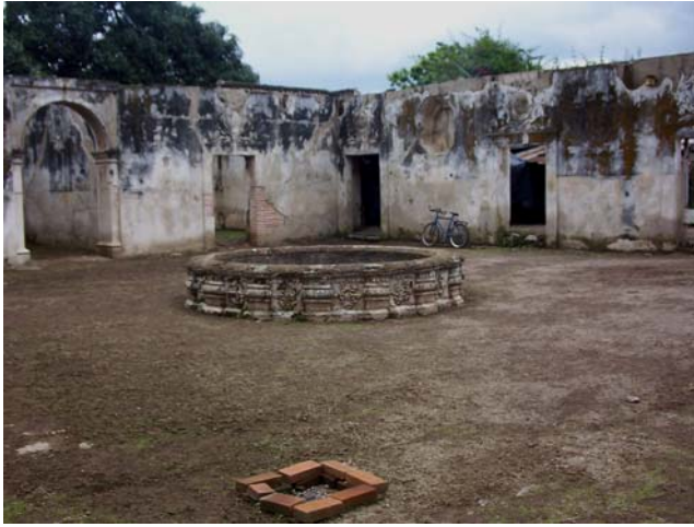
索潢娜修道院主庭園現況
