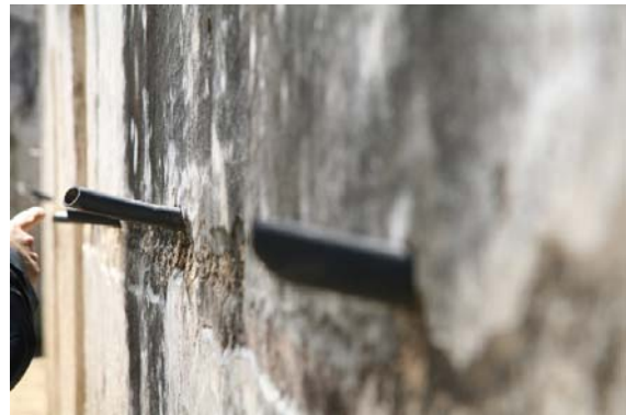
使用灌注膠著劑方式強化牆體
