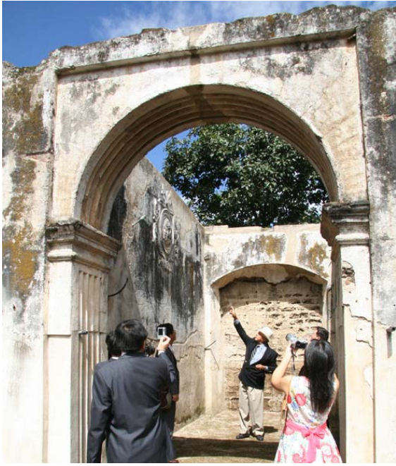
原入口已被磚牆封死
