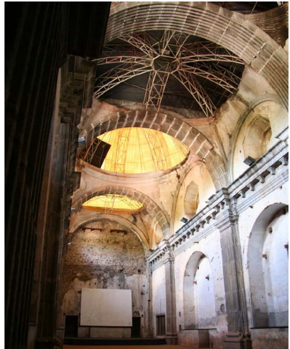
修女彌撒小教堂，因1976年大地震致屋頂倒塌。 原屋頂殘蹟（左圖）；1993年採碳纖維拱狀屋頂保存殘蹟（右圖）
