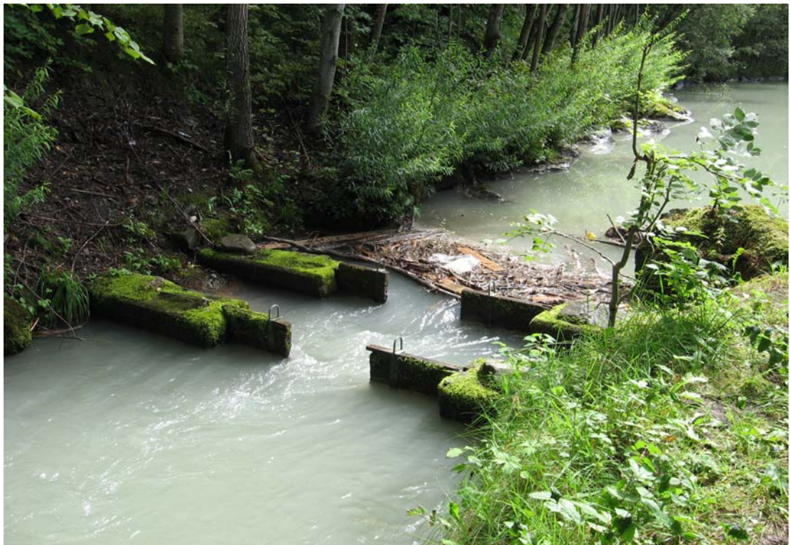
照片 30 魚道出口（上游水流流入處）施設攔阻漂流木布置
