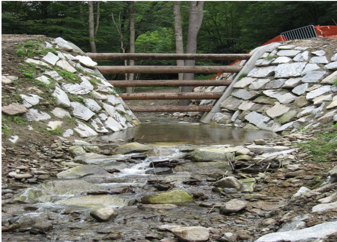
照片 17 攔砂壩中間之攔砂閘使用圓木頭材料
