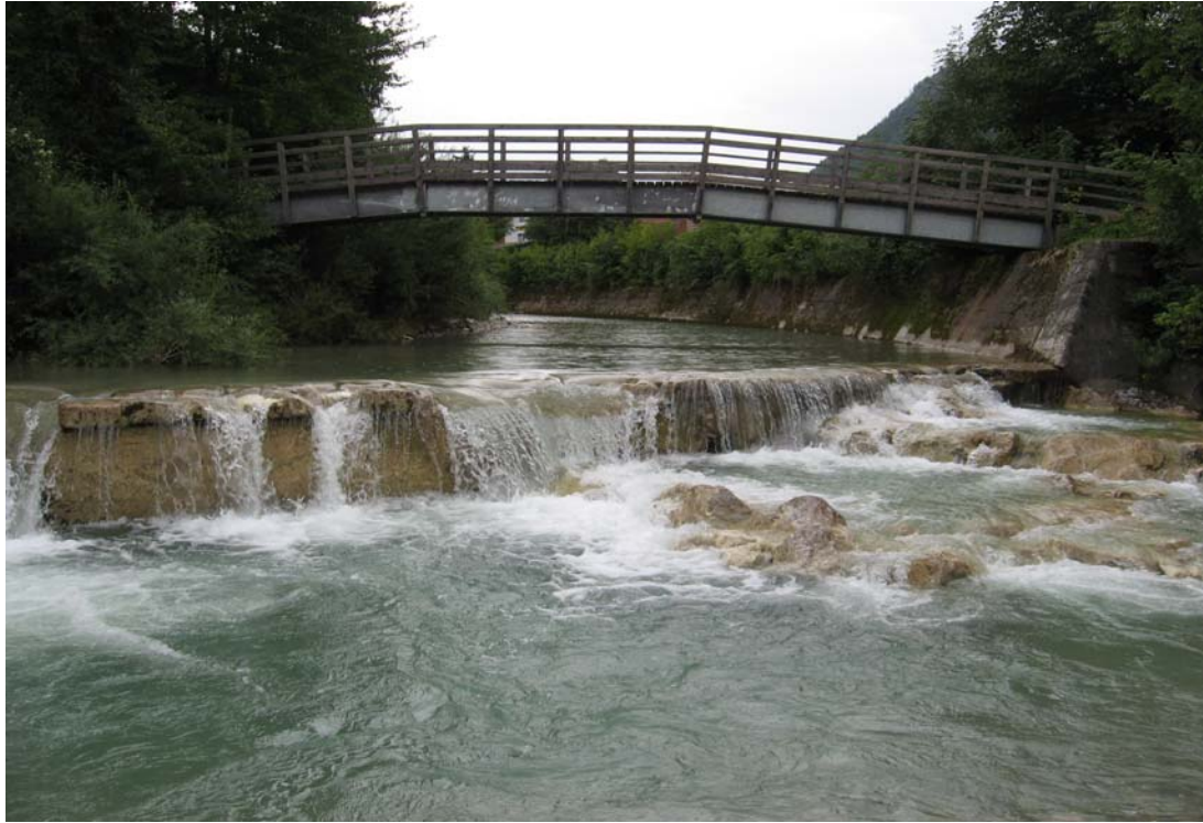
照片 43 既有攔河堰採用大塊石增設魚道
