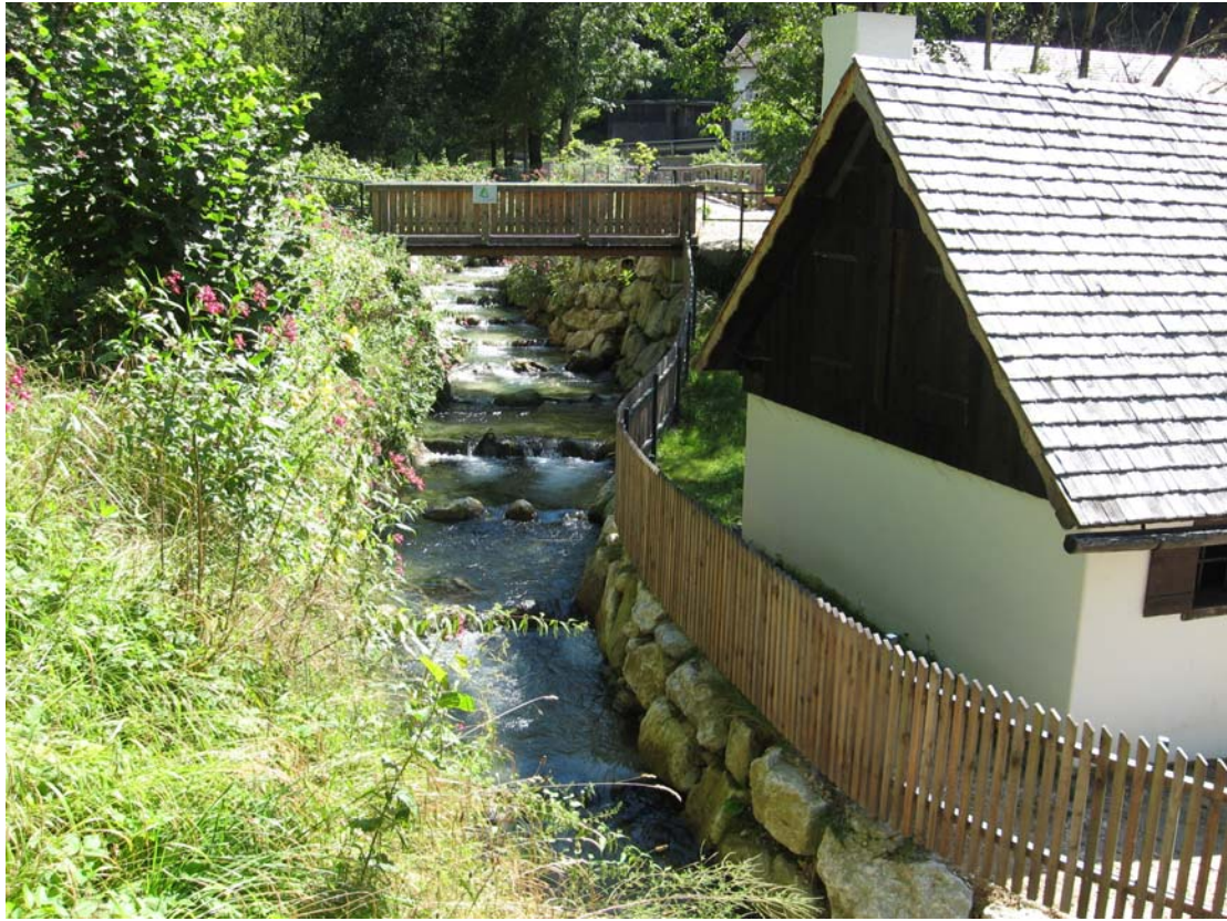
照片 33 繞行魚道 (Bypass Fish Way) 流況
