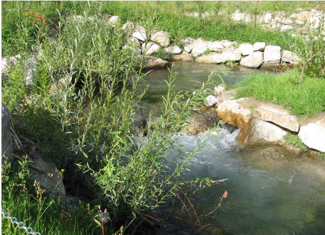
照片 35 魚道兩側種植樹木提供遮蔭及綠美化
