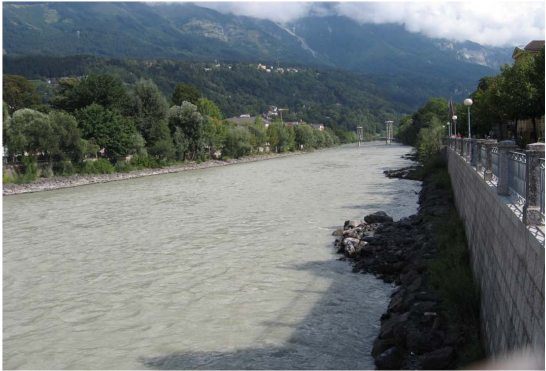
照片 11 河溪拋塊石丁壩護岸工程
