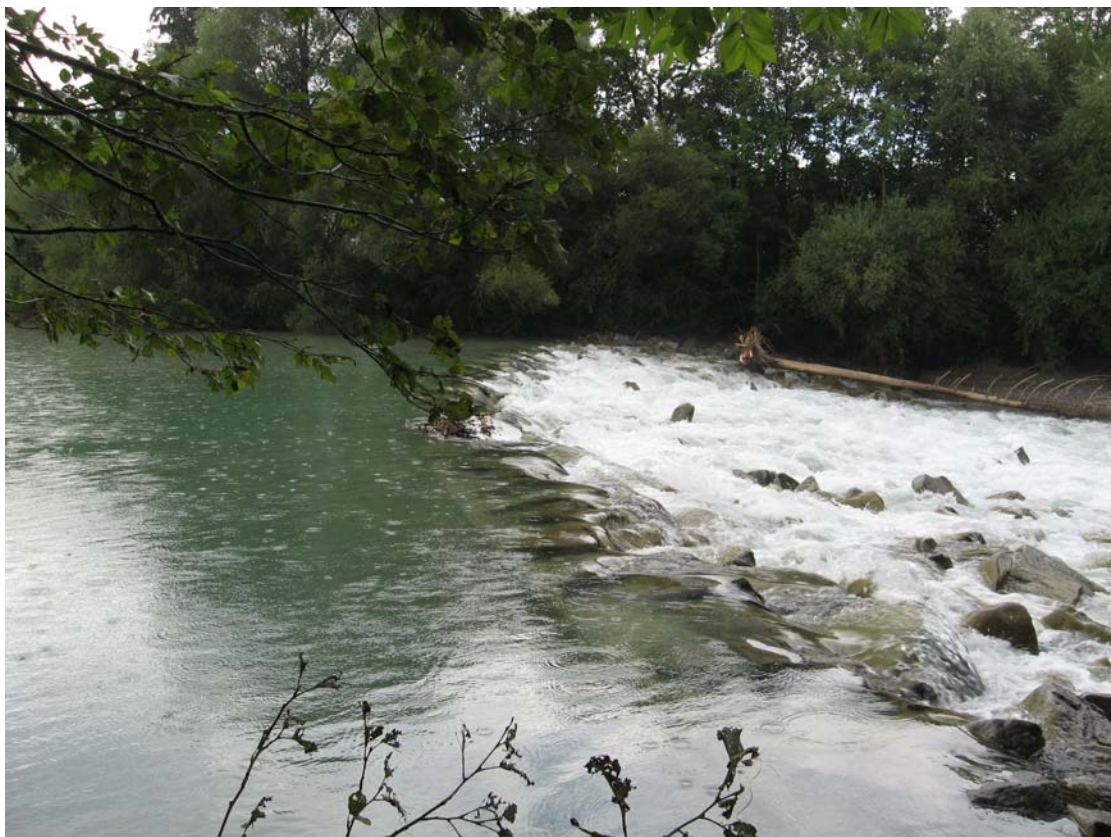
照片 22 乾砌塊石彎拱形 (Arch) 固床工可兼做魚道使用
