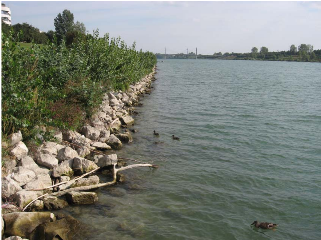
照片 6 河溪拋塊石護岸工程
