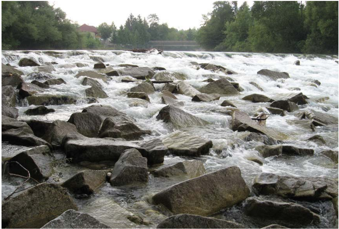
照片 23 乾砌塊石彎拱形 (Arch) 固床工可兼做魚道使用
