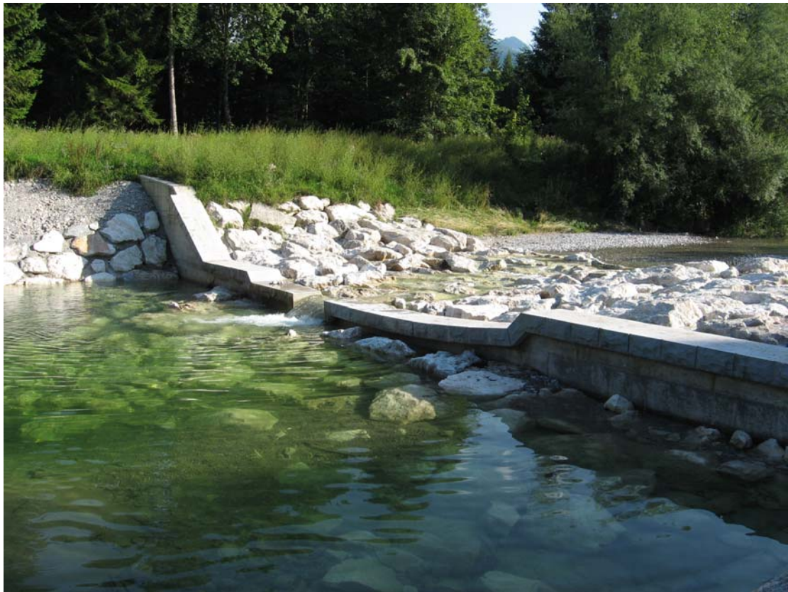
照片 20 混凝土固床工上、下游以拋塊石穩定河床
