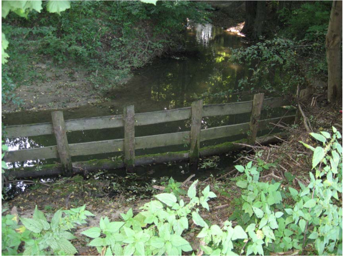
照片 27 軟弱土壤區之河道轉彎處布置木樁圍籬護岸工程
