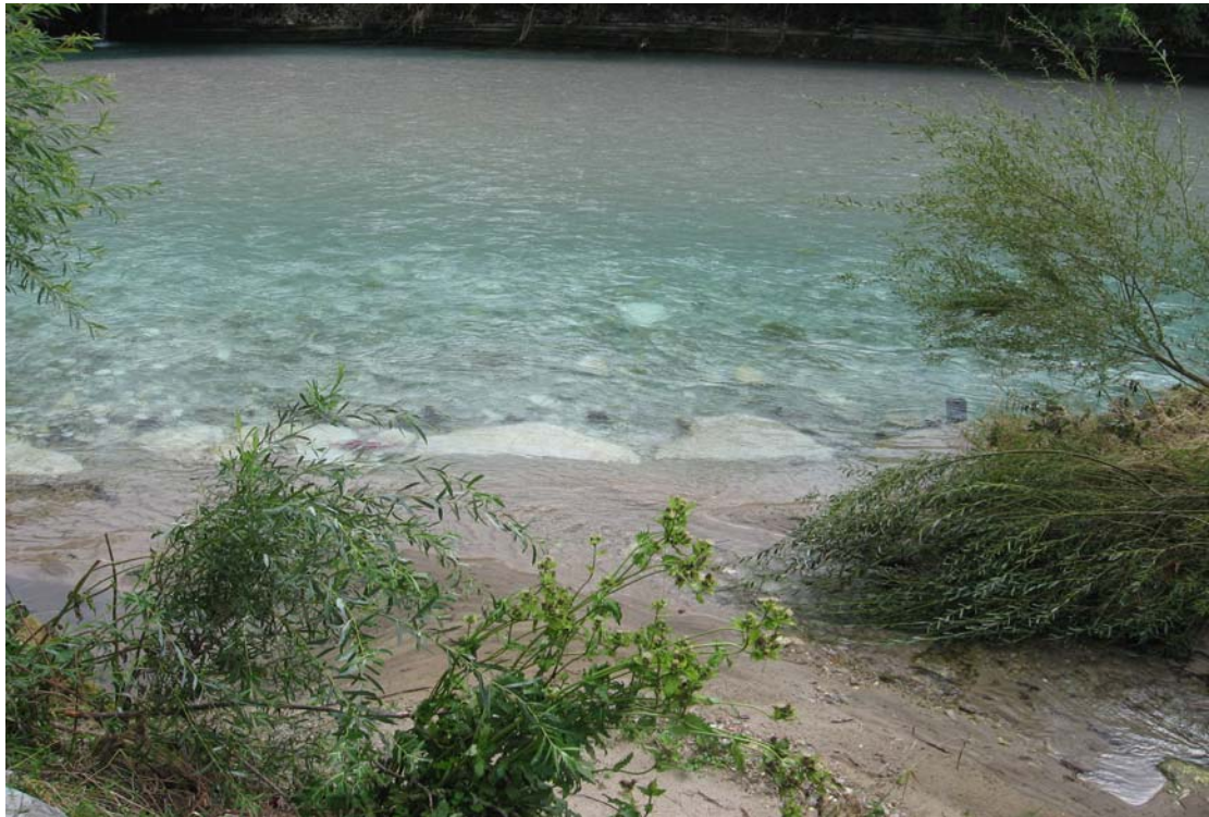
照片 21 河溪主支流交匯處布置鐵樁與乾砌塊石避免落差產生
