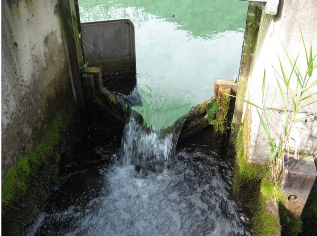
照片 29 魚道出口（上游水流流入處）附設 V 型量水堰
