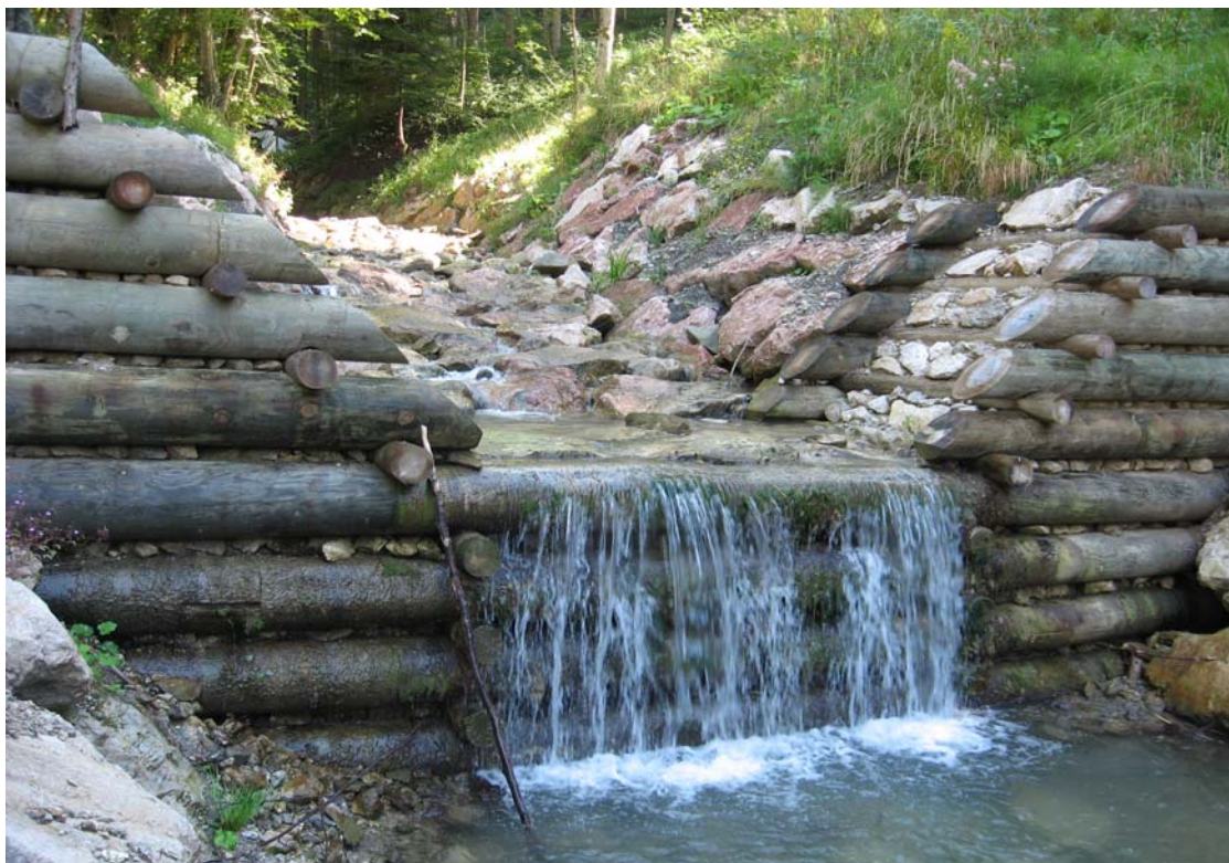
照片 18 木頭搭配乾砌塊石固床跌水工程
