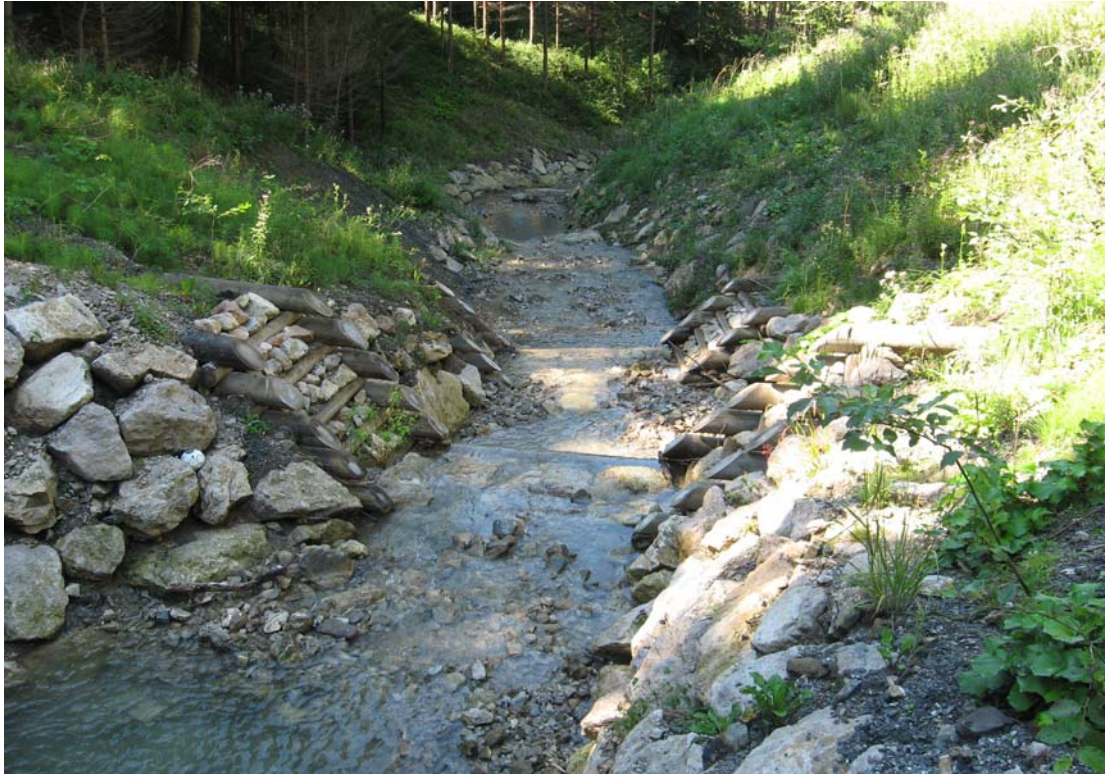
照片 7 河溪乾砌塊石護岸工程
