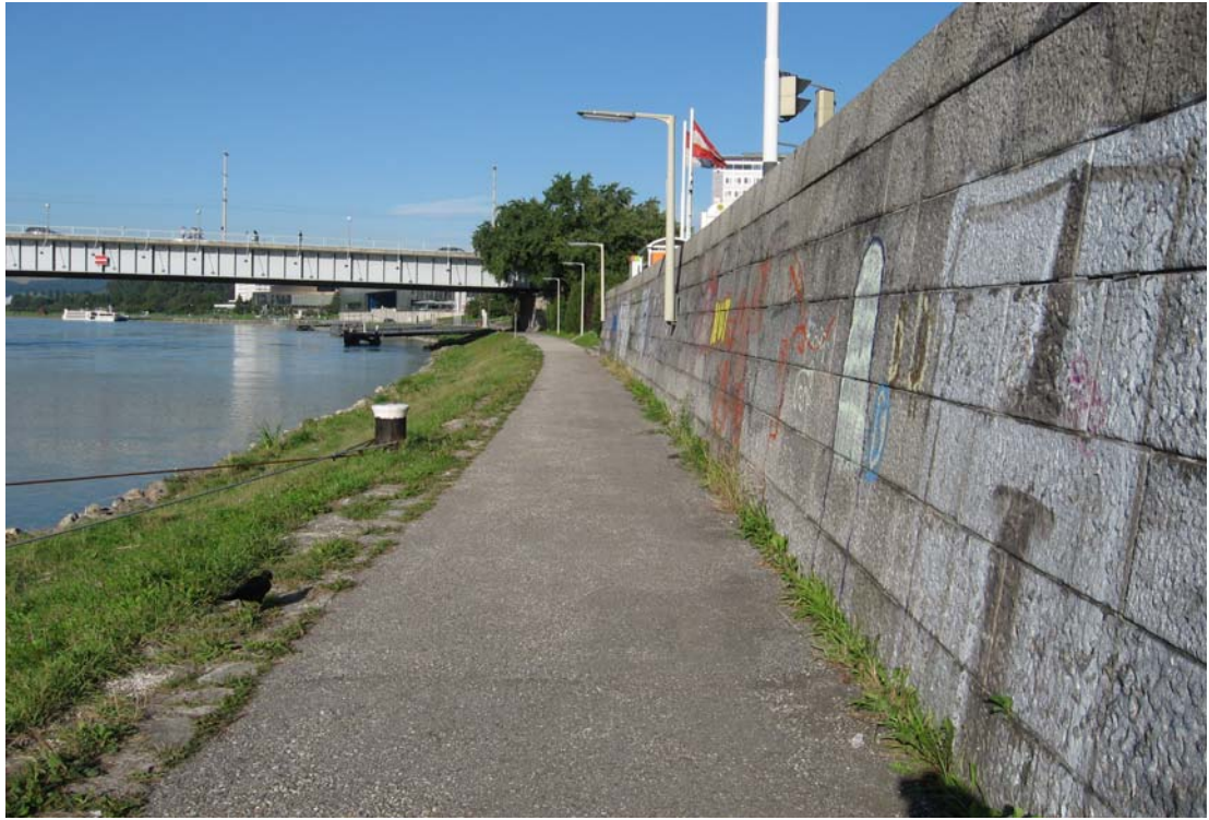
照片 13 都會區河溪拋塊石護岸及防洪牆工程
