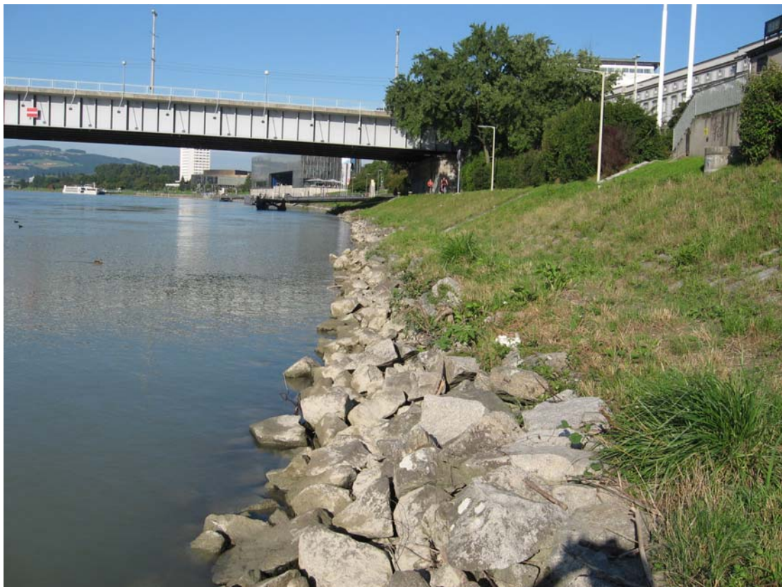
照片 12 河溪拋塊石護岸工程
