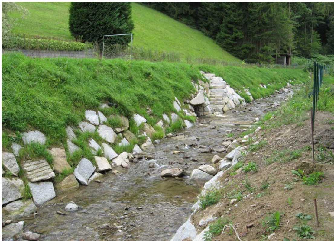
照片 8 河溪乾砌塊石護岸工程完工後植生覆蓋恢復情形良好
