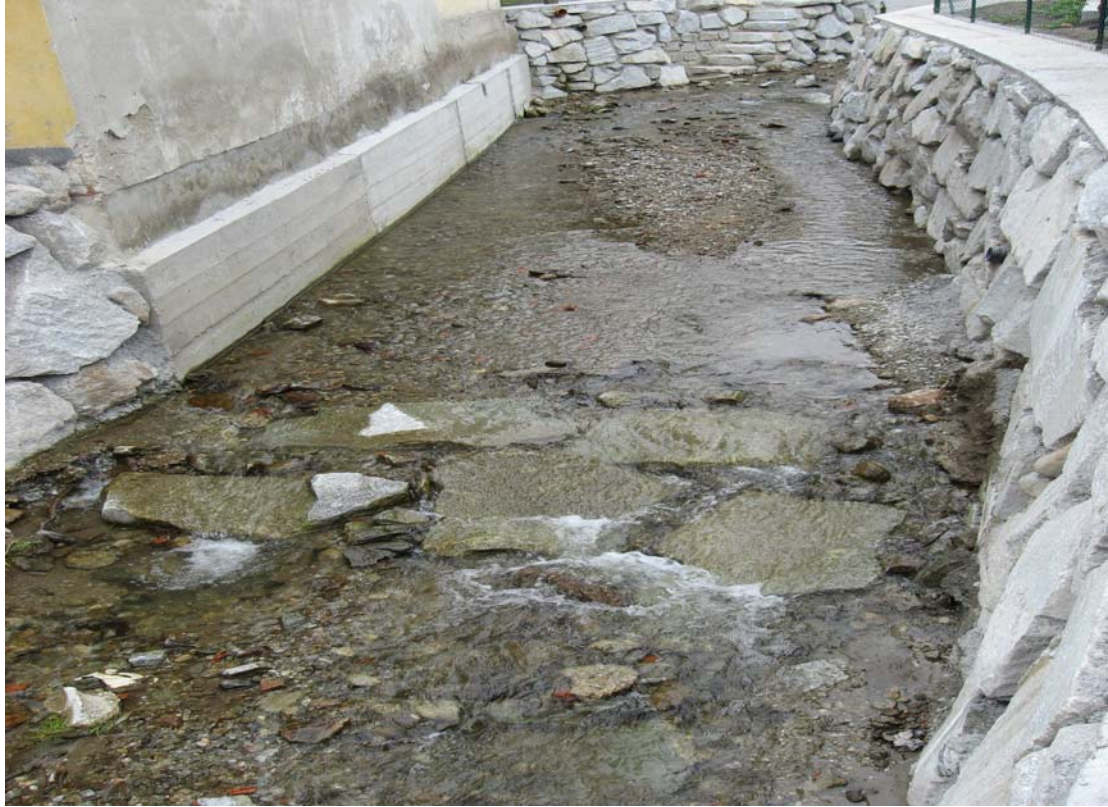
照片 9 靠近住宅處使用混凝土及漿砌塊石工程布置以確保安全
