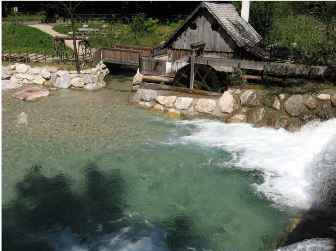
照片 45 設計較不佳之魚道入口（遠離水流紊流區）
