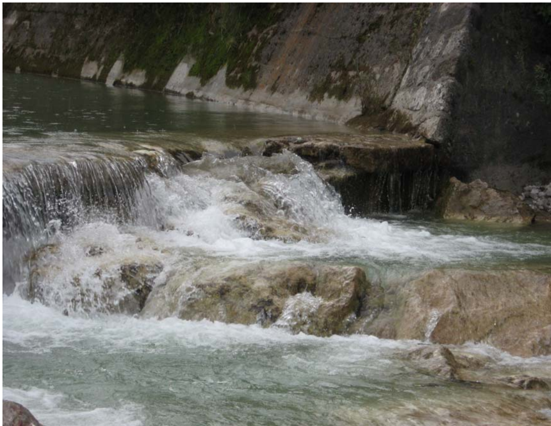
照片 44 既有攔河堰採用大塊石增設魚道
