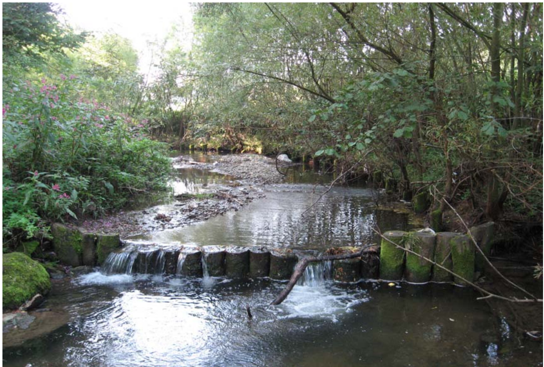
照片 28 軟弱土壤區之河道布置木樁固床工及護岸工程
