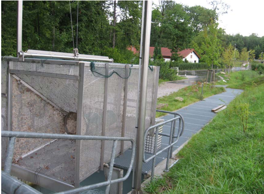
照片 31 魚道出口（上游水流流入處）附設魚類上溯量計裝置
