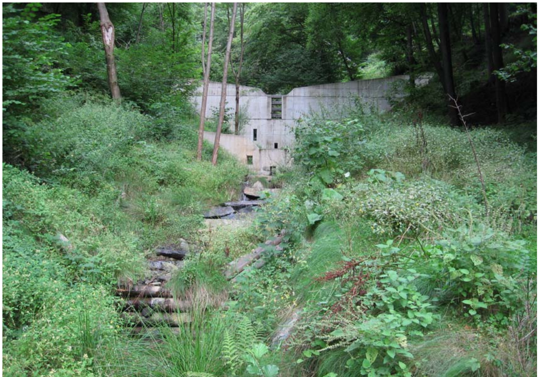
照片 16 攔砂壩不同位置設置開口避免阻斷水中生物通道
