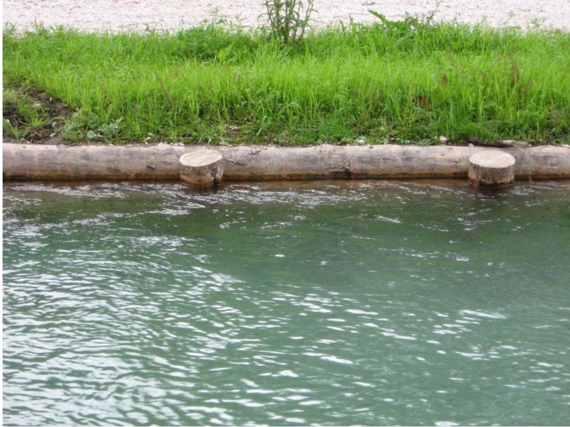
照片 25 河溪木製護岸工程
