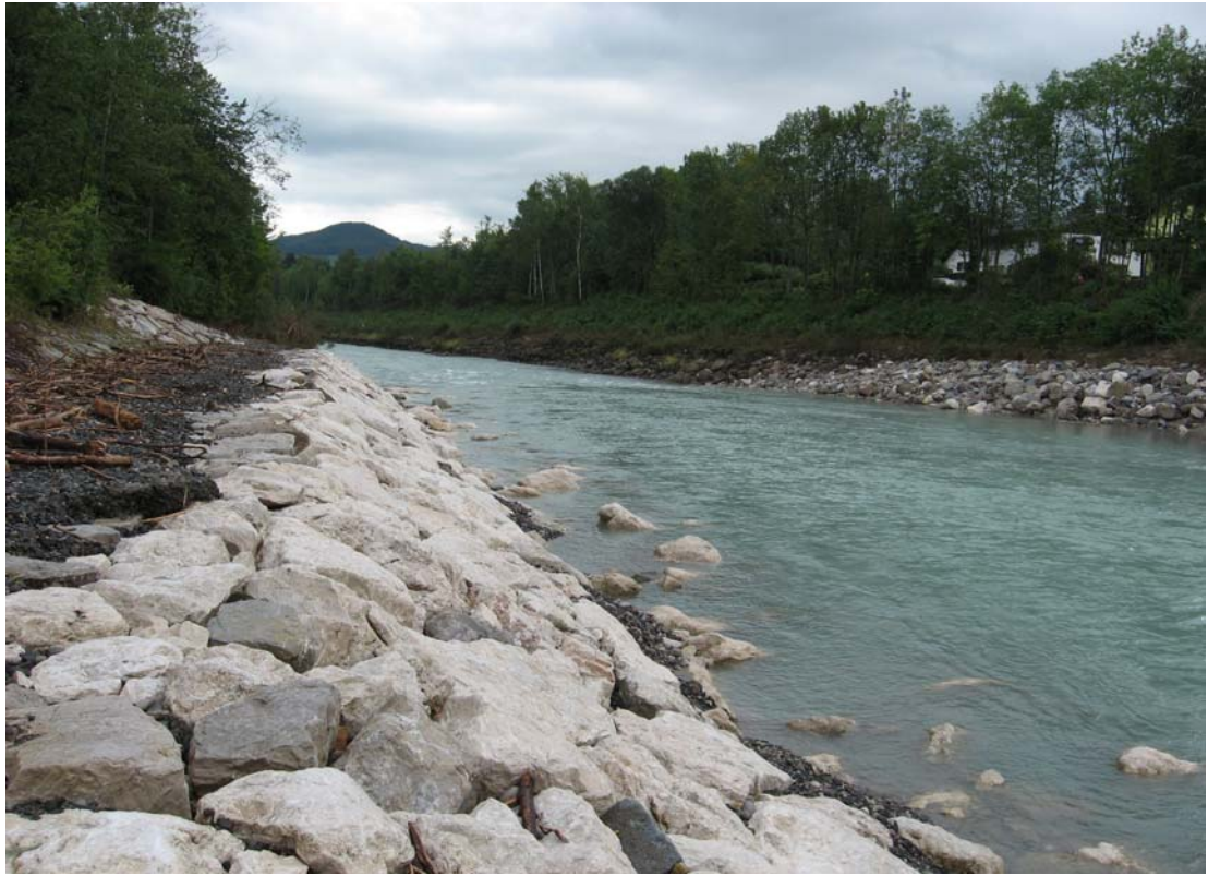
照片 5 河溪乾砌塊石護岸工程
