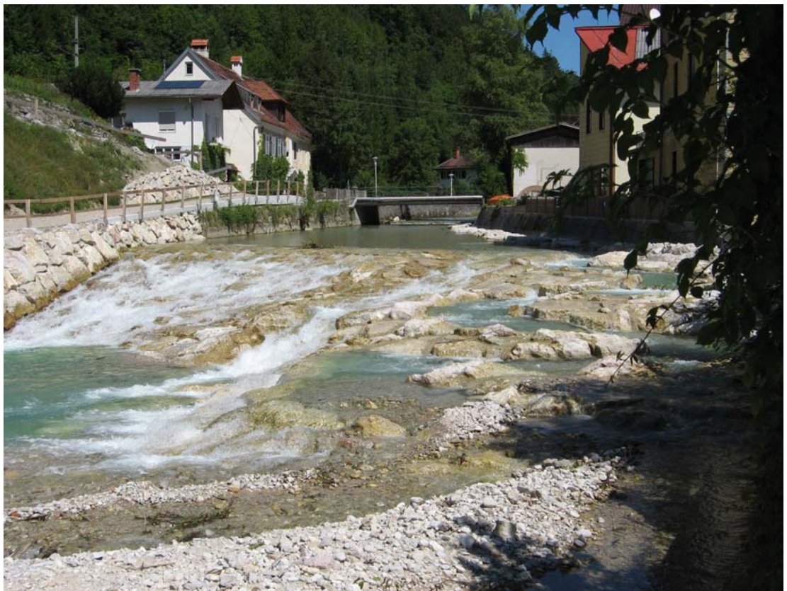
照片 42 攔河堰布置傾斜面魚道與水池式魚道
