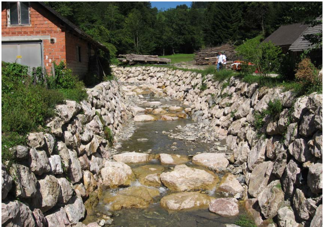
照片 4 河溪乾砌塊石護岸工程
