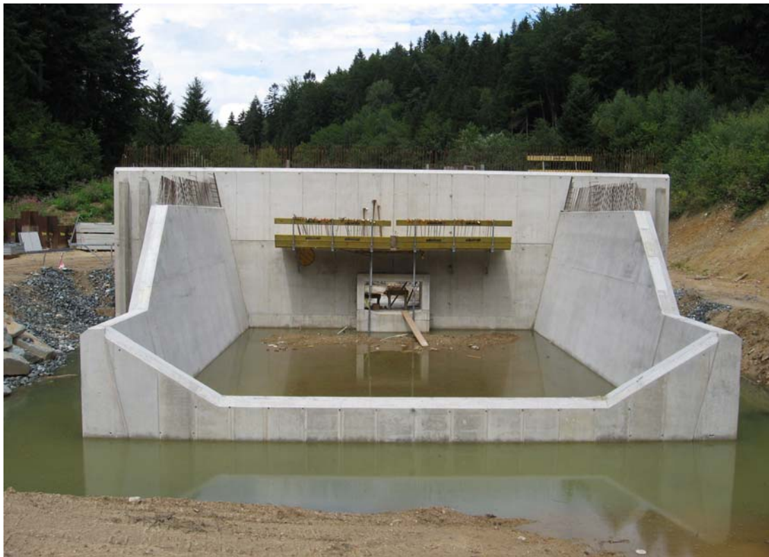
照片 14 滯洪壩壩體中心部分以混凝土建造（施工中）
