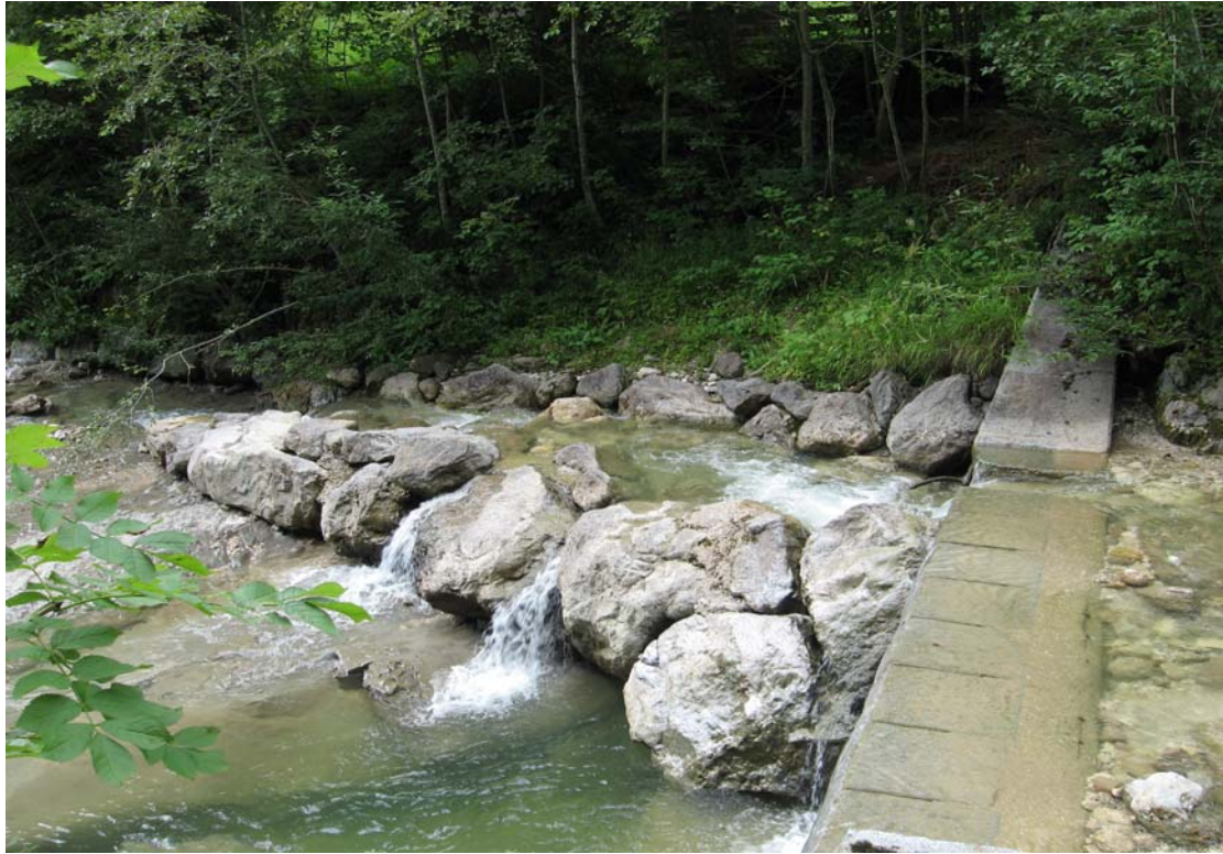
照片 41 既有攔河堰採用大塊石增設魚道
