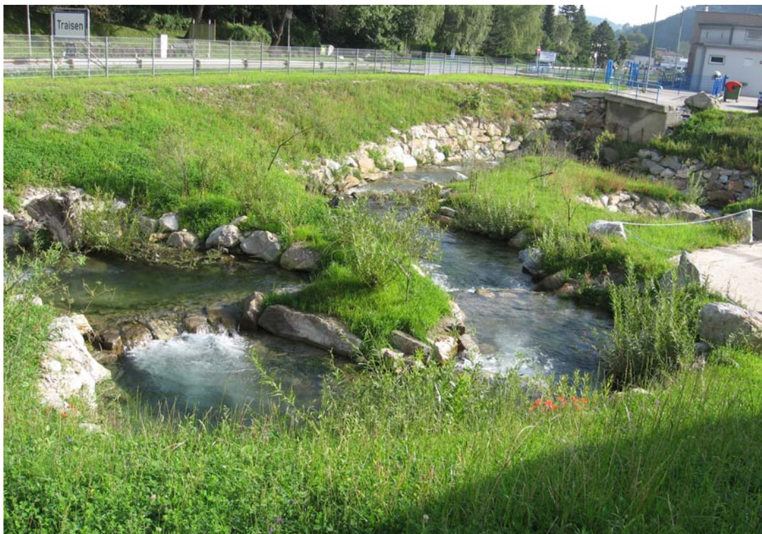
照片 34 魚道設計多處轉彎以減小水池間之落差
