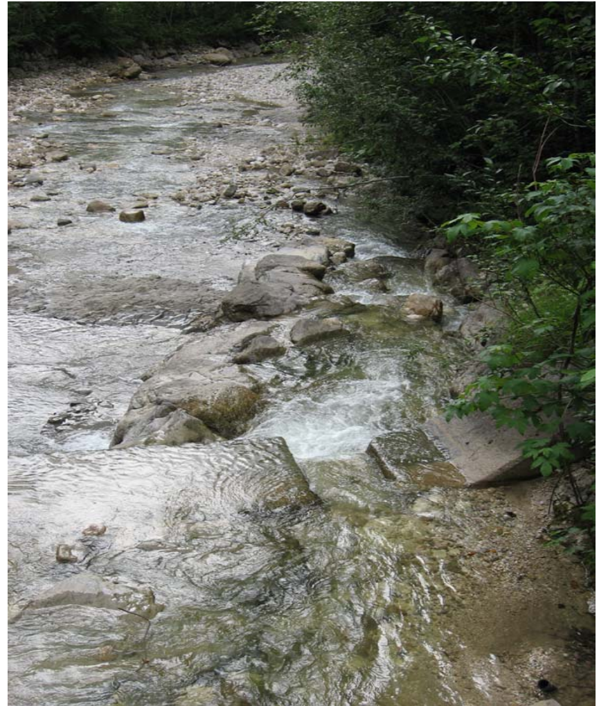
照片 40 既有攔河堰增設魚道設施
