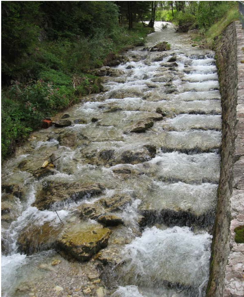
照片 39 水池式魚道流況
