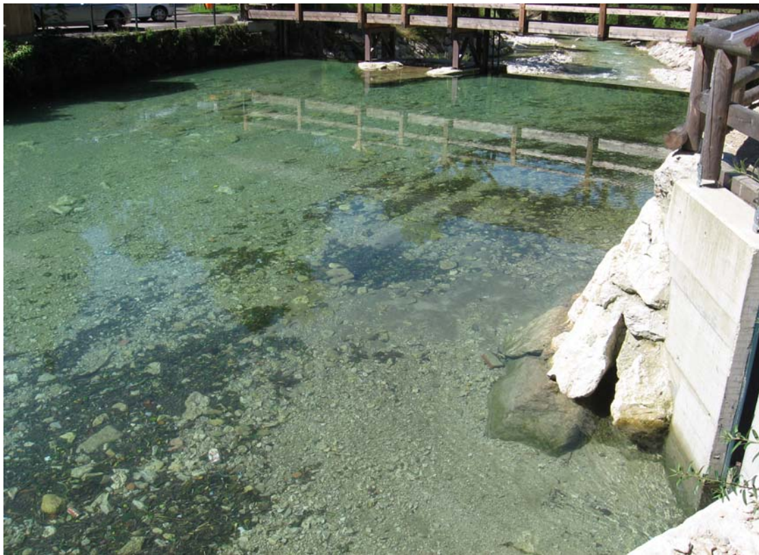
照片 32 魚道出口（上游水流流入處）水質清澈適合魚類生存
