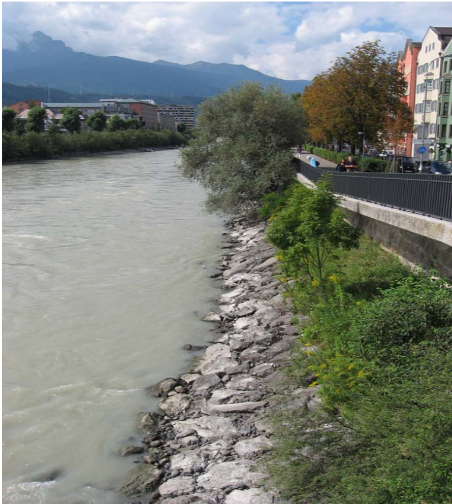
照片 55 都會區河道防洪牆前拋塊石及植樹綠美化
