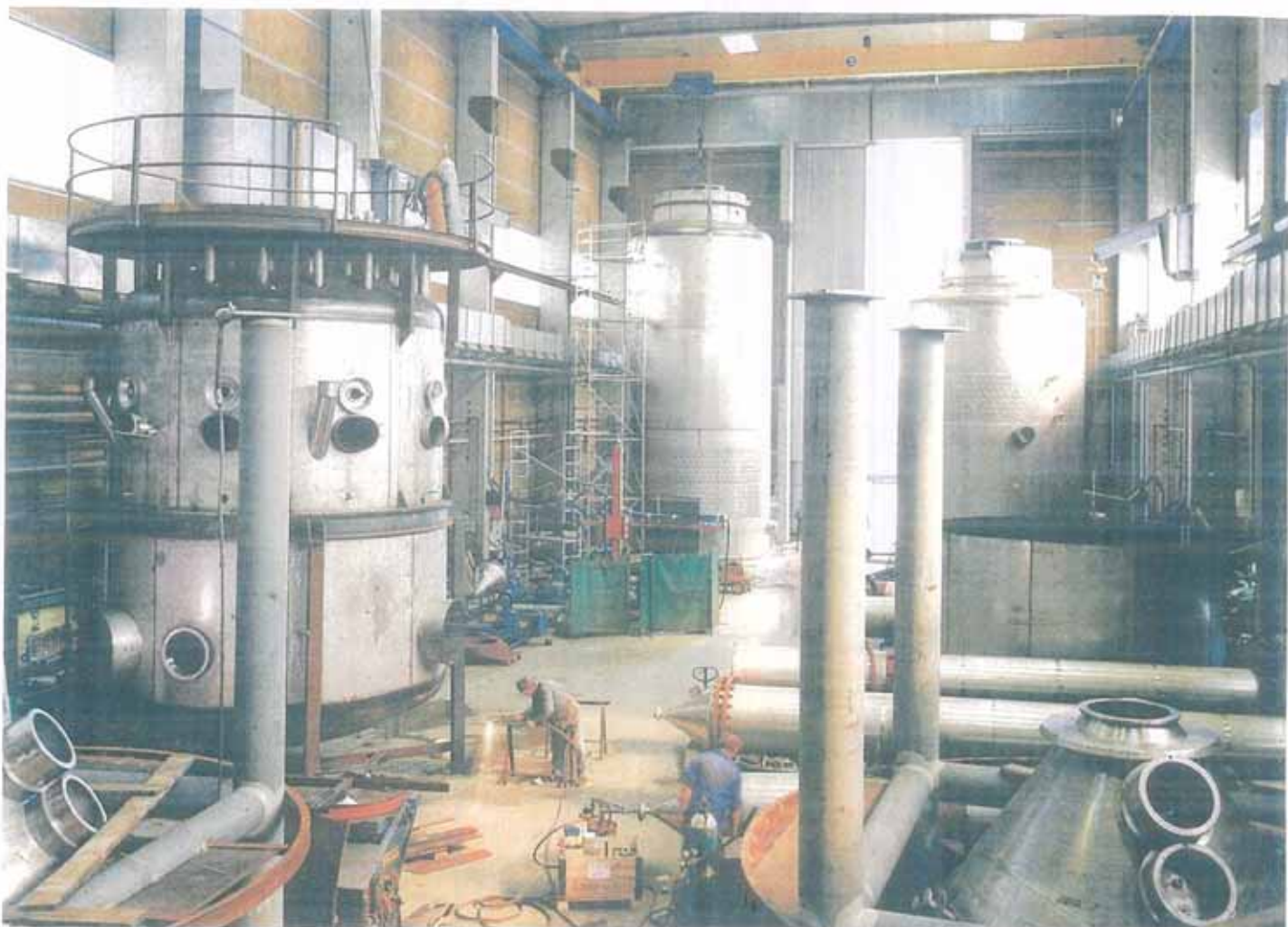
Produktions- og montagehal. Løftehøjde under krankrog: 15 m. Løftesvgt: 30 t.
