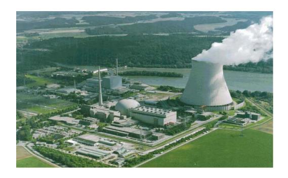
Isar 核能電廠有兩部機,一號機為 BWR ,容量為 912 MWt; 二號機為 PWR,4-Loop, 容量為 1475MWt,發電機為 1500 rpm, 1640MVA。本次參訪機組為 Isar 2。
