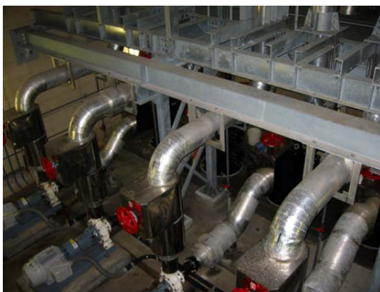
圖 11 深層水取水管—取水設施設於低於海平面 10 公尺下之水泥構造物內，利用深層海水湧升壓力及虹吸作用即可汲取海水
