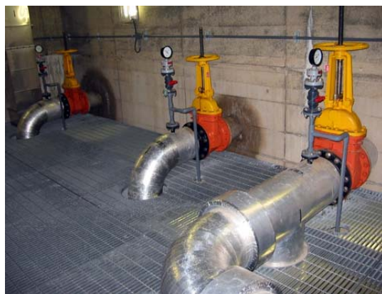
圖 11 深層水取水管—取水設施設於低於海平面 10 公尺下之水泥構造物內，利用深層海水湧升壓力及虹吸作用即可汲取海水
