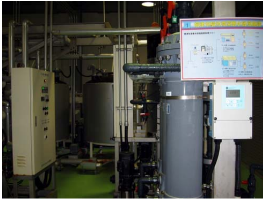
圖 7 駿河灣深層海水取水後脫鹽設備，下圖為說明圖
