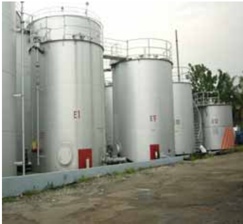
(船舶供油儲槽)
